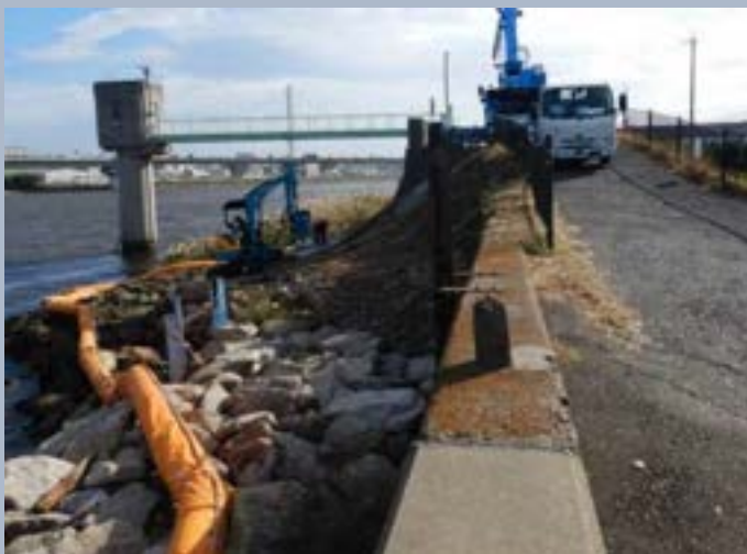
下流高潮堤防の補修工事
