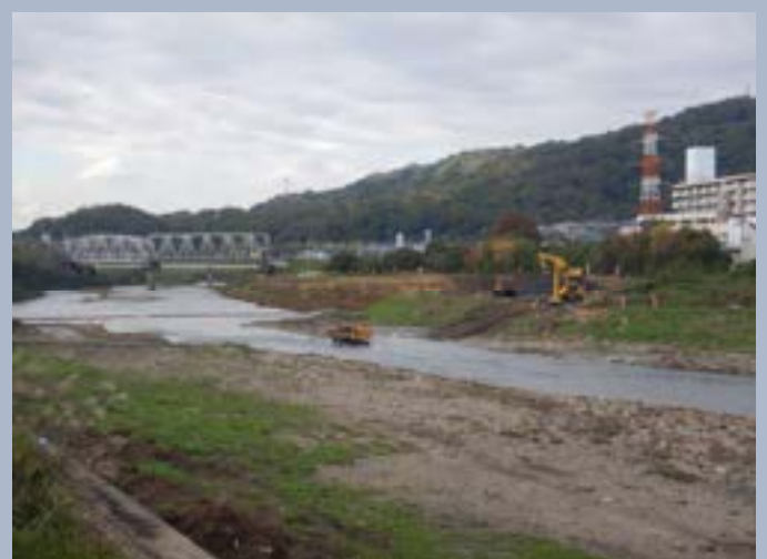
河川内の掘削工事
