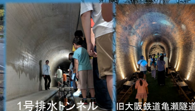
1号排水トンネル
