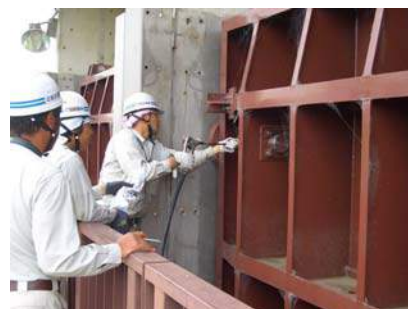
機械設備の点検状況
