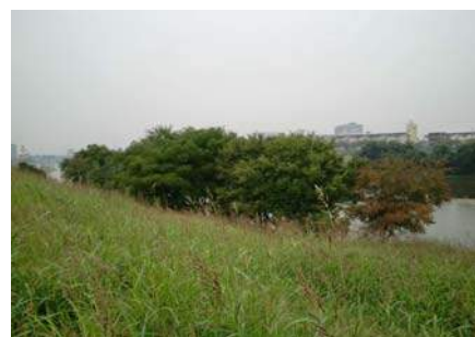
河道内樹木の繁茂状況
