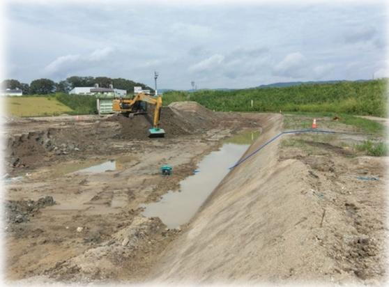
9月15日時点8,000m<sup>3</sup>掘削しています
