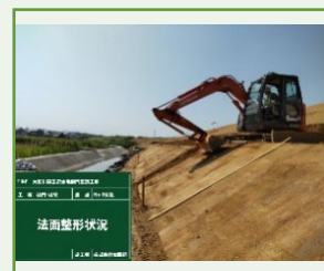
法面整形状況
