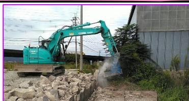
超低騒音型ブレーカ使用での取壊し作業
