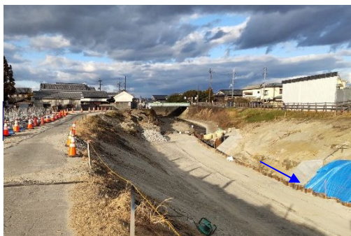
秋篠川(護岸改修工事)
