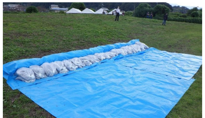
改良土のう工 完成
