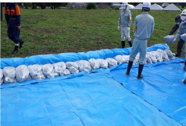
土のう袋積みの様子
