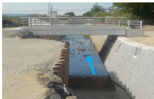
小金打川(護岸改修工事)
