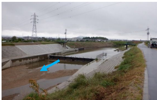
曾我川(護岸改修工事)
