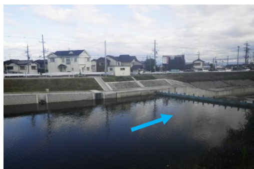
富雄川(護岸改修工事)
