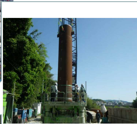
鋼管杭打設状況
