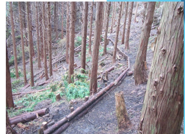
(間伐木を利用した丸太筋工)
