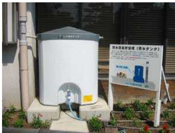
雨水タンク設置状況
