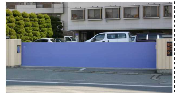
指定耐水施設での耐水化対策 (浸水防止壁)の事例
