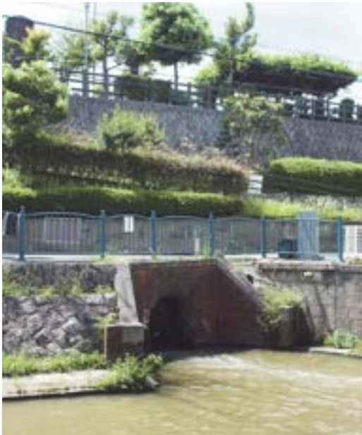
大和川の堤防・治水記念公園下の二番樋出口
