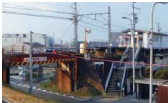
近鉄柏原南口駅と国道25号線 左が大和川鉄橋
