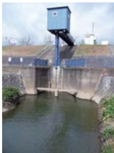
青地樋 大和川からの水の取り入れ口
