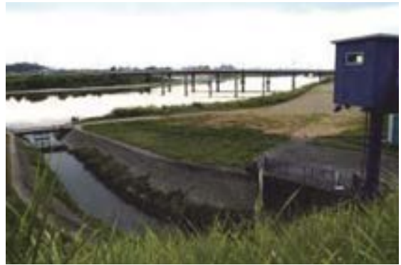
大和川の二番樋取り入れ口
