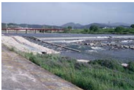
2010年に完成した柏原堰堤 えんてい の魚道 近鉄道明寺線鉄橋の下流側
