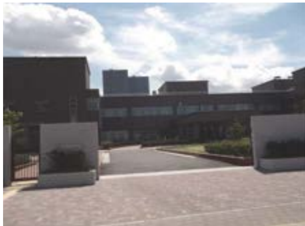
竜華水みらいセンター管理棟
