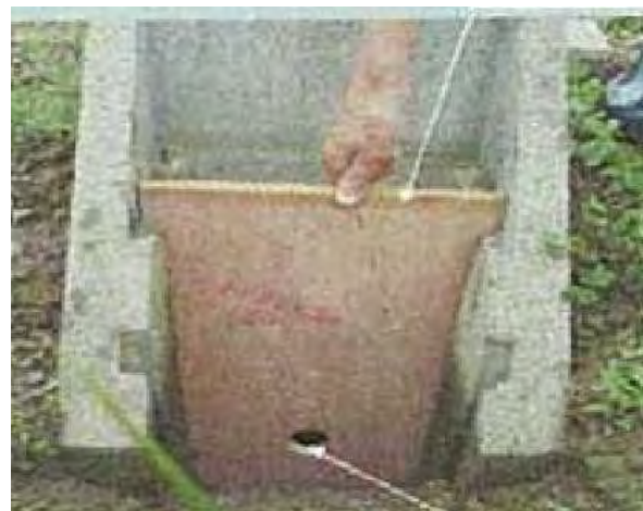
排水柵の改良
