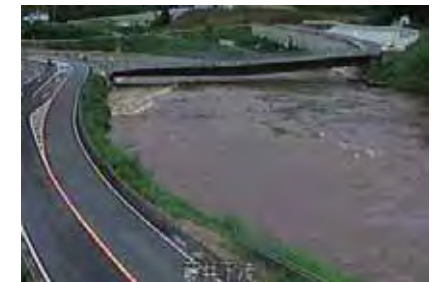
平成26年台風11号 (大和川・王寺町)
