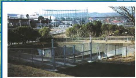
**防災調整池** 宅地造成等の市街地開発では河川への流出量が増大するため、防災調整池によって雨水を一時的に貯留し、流出を抑制します。
