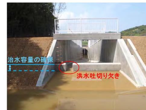
洪水吐切り欠きの設置により治水容量の確保を行った事例
