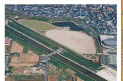
**遊水地** 河川の流水を遊水地内に越流させることにより、下流の氾濫を軽減します。
