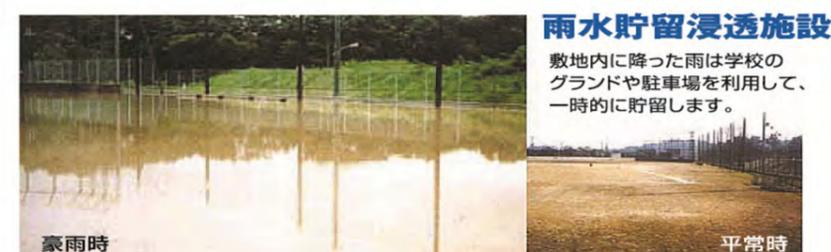
**雨水貯留浸透施設** 敷地内に降った雨は学校のグラウンドや駐車場を利用して、一時的に貯留します。
