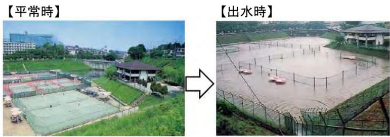
雨水貯留浸透施設の例(防災調整池)
