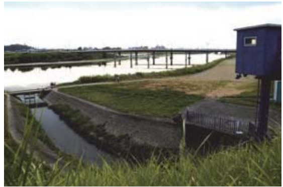
大和川の二番樋取り入れ口
