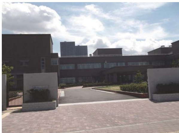
竜華水みらいセンター管理棟
