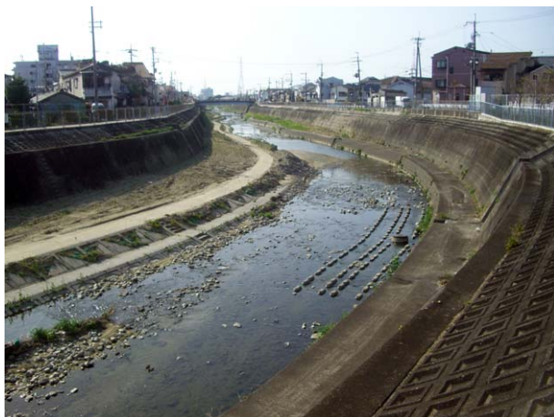
高木橋から北西方向。右手が元の川すじ。川の中に、薄層流浄化法による河川浄化のための礫やブロックが置かれている
