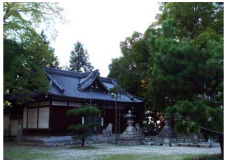
大堀4丁目にあった遷座前の大堀八幡神社 2010年
