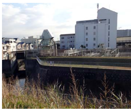
小山ポンプ場 大和川堤防から撮影 手前は落堀川 左が南からの水路
