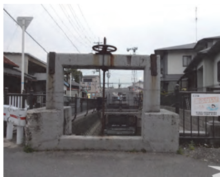
古箕輪「水路の交差点」の藤五郎樋 以前は管理用の建物があった
