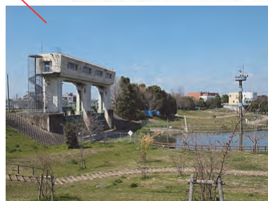
寝屋川への排水門と公園内の深野池
