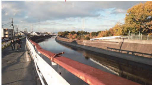
右岸遊歩道と寝屋川 右手奥が深北公園の越流堤
