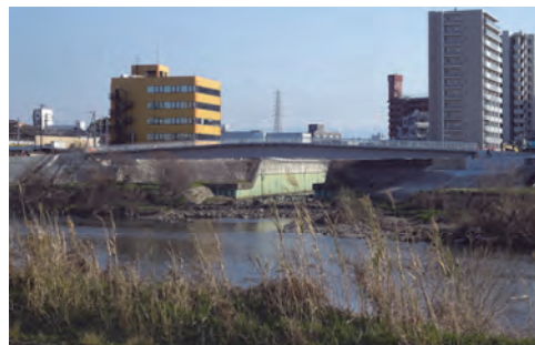
2025 年 3 月 大和川に注ぐ西除川河口 サイクリングロード整備で新しく浅香山橋ができた
