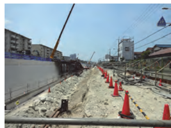
2021年8月 西除川復旧工事中
