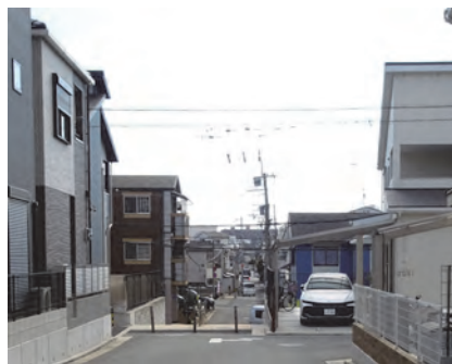
南島町1丁 手前が高規格堤防先行整備街区の新しいまち。段差の向こうが旧街区 2025年2月
