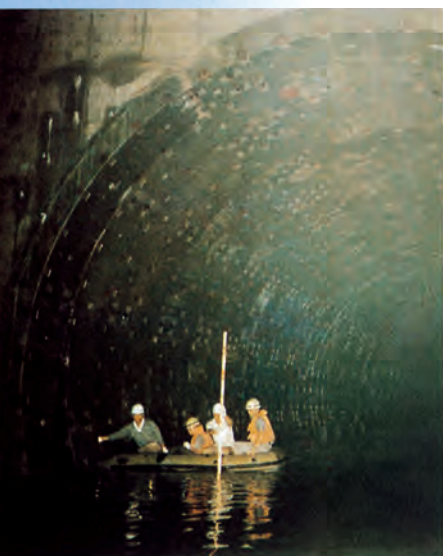
▼寝屋川南部地下河川
