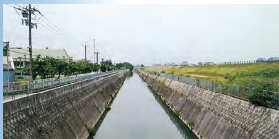
▲落堀川 右の土手は大和川の堤防
