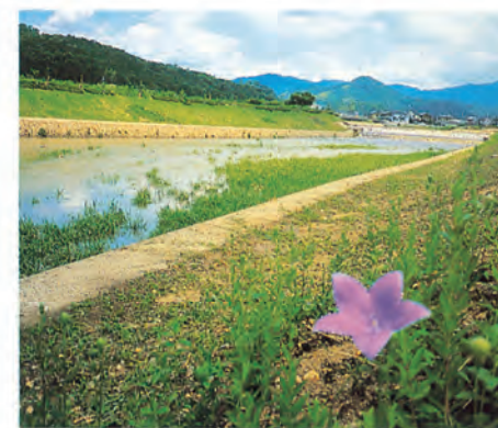
▲④初瀬川 (桜井市金屋付近)
