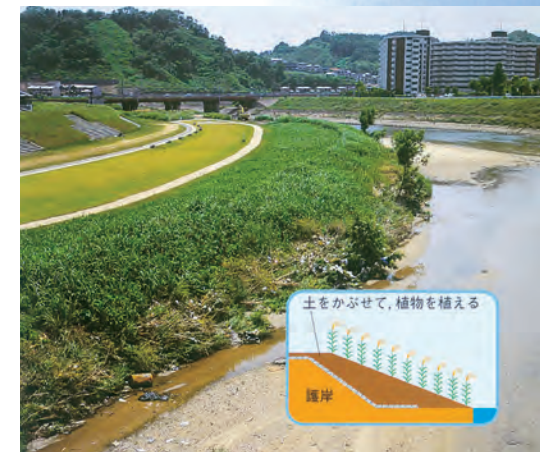
▲多自然川づくり
