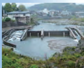
▲水のとり入れ口がある しもぶちとうしゅこう 下湊頭首工（大淀町）
