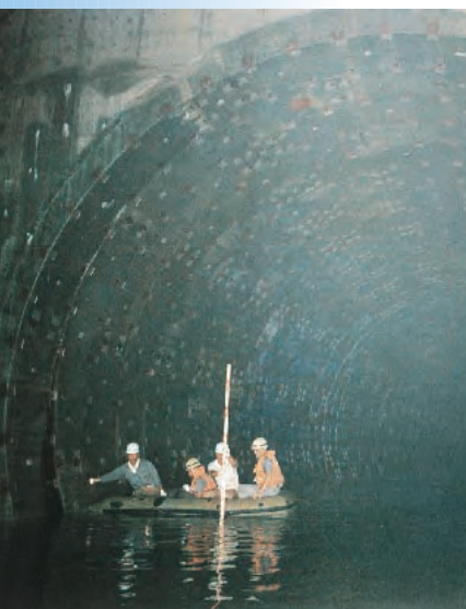
▼寝屋川南部地下河川
