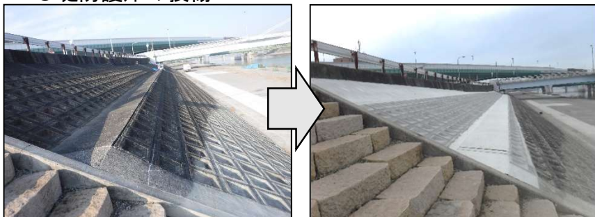
護岸の損傷箇所を 復旧
