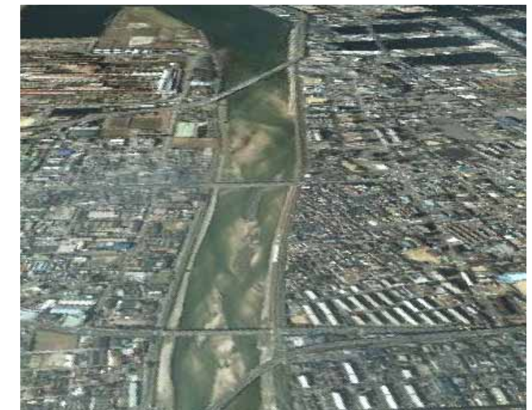
写真 2.1.4 大和川の河口の堆砂状況
