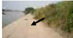
コンクリートの低水護岸が敷設されており、水際植生はない
