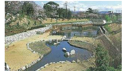
ため池治水利用施設: 鰻堀池・大和郡山市
