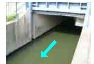
落差がなく移動が可能な水路 (佐保川2.3km付近 美濃川樋門)
