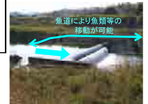
曾我川取水堰の魚道
