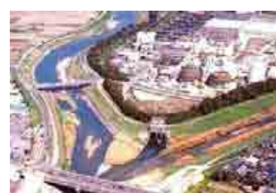
写真3.5 奈良県浄化センター (長吉長原地区)
