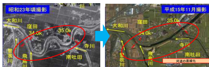
図 2.4 捷水路による瀬淵の減少(大和川 35k 付近)
