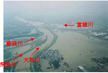
写真 1.14 安堵町・河合町・斑鳩町付近 (平成 11 年 8 月洪水)
