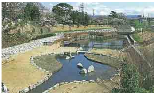
写真 1.19 ため池治水利用施設: 鰻堀池・大和郡山市
