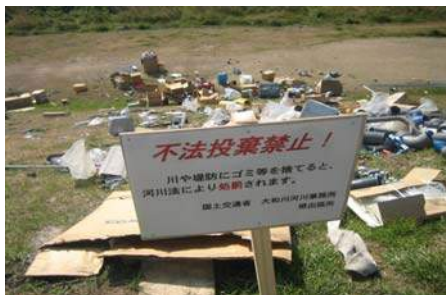
写真4.21 堤防上での不法投棄
