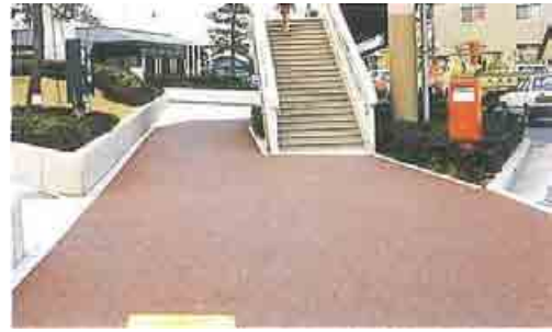
写真 1.22 透水性舗装(斑鳩町役場前)
