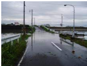
写真 1.15 天理・王寺線 (川西町付近) (平成 19 年 7 月洪水)
