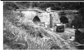
昭和6~7年の地すべり （国鉄関西本線の崩壊）
