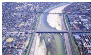
写真 1.32 下流部の交互砂州の状況
