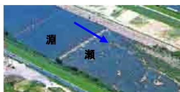
写真3.4 河川浄化施設 (長吉長原地区)
