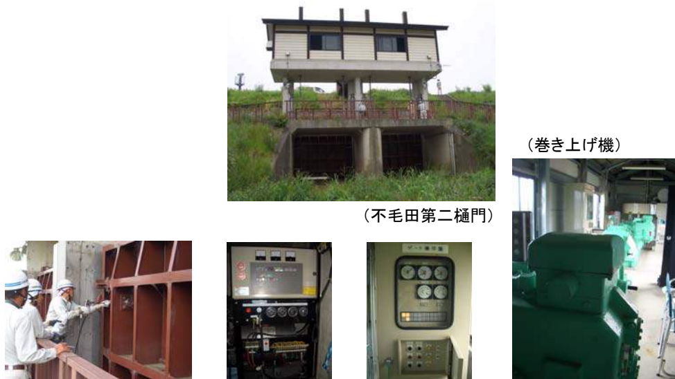
写真 4.11 機械設備の点検状況
