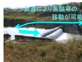
写真4.3 曾我川取水堰の魚道
