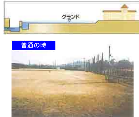
写真 1.23 雨水貯留浸透施設(広陵町立真美ヶ丘中学校)
