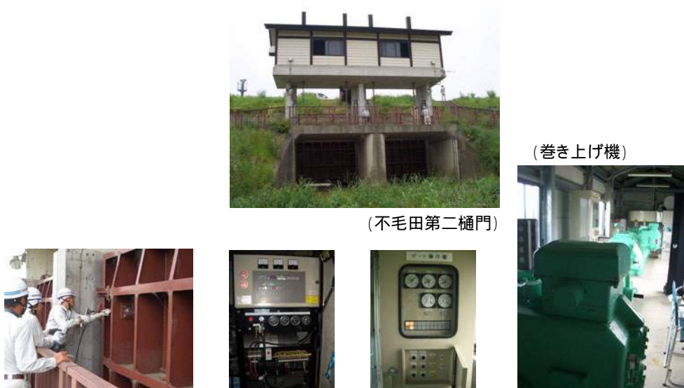
写真 4.9 機械設備の点検状況
