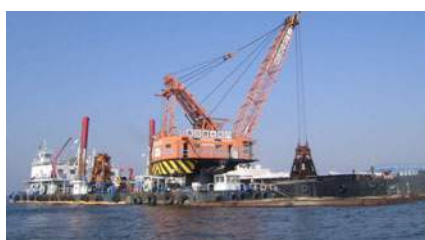
河口部土砂浚渫
