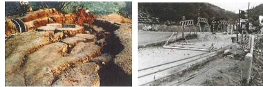
写真 1.24 昭和 42 年の地すべりによる被害
