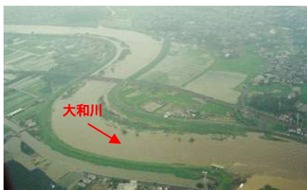
写真 1.12 河合町付近 (平成 11 年 8 月洪水)
