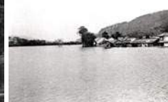
昭和 6~7 年の地すべり (大和川上流の浸水)
