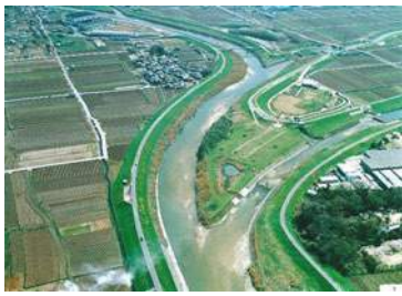
写真 1.25 中流部の状況
