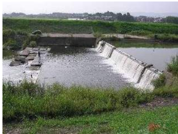
写真 2.1 堰による落差 (須原井堰、佐保川 1.3k)
