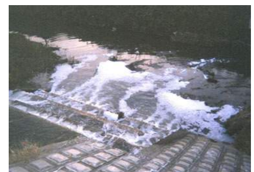
写真 2.10 飛鳥川に排水される濁水
