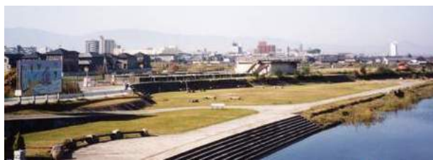
写真 2.13 初瀬川金屋河川公園
