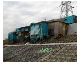
写真3.5 不法占用の状況
