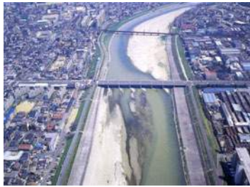
写真 1.31 下流部の状況
