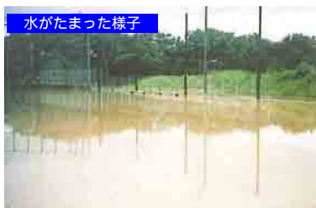
写真 1.20 防災調整池 (工場造成に伴う調整池・上牧町)
