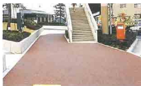
写真 1.21 透水性舗装(斑鳩町役場前)
