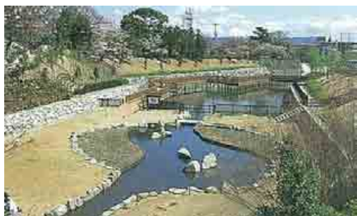
写真 1.18 ため池治水利用施設 (鰻堀池・大和郡山市)
