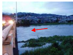
写真 1.17 藤井観測所より 右岸を望む(大正橋付近) (平成 19 年 7 月洪水)
