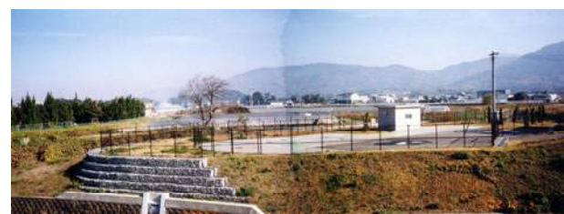
写真 2.11 三輪川浄化施設
