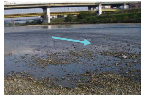
巨石投入による瀬・淵の再生
