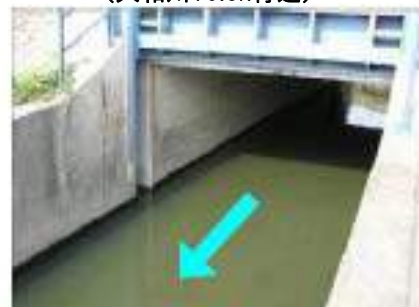
落差がなく魚類等の移動可能な水路
