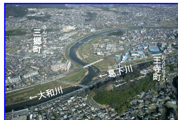
JR大和路線第二大和川橋梁付近 (大和川27.0km付近)
