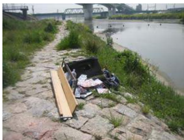
国道 26 号大和川大橋付近(右岸)
