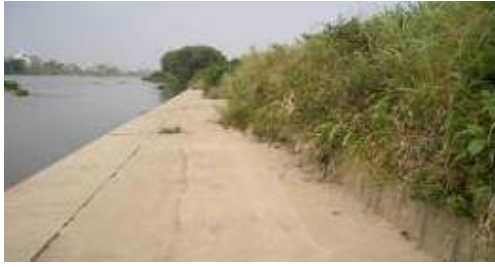
写真2.4 下流部の水際状況 (今井戸川合流部、大和川 7.6k)
