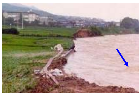
写真 2.22 昭和 57 年 8 月洪水 (石川 昭和橋上流右岸)
