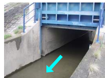
写真4.4 落差がなく移動が可能な水路 (佐保川2.3k付近 美濃川の樋門)
