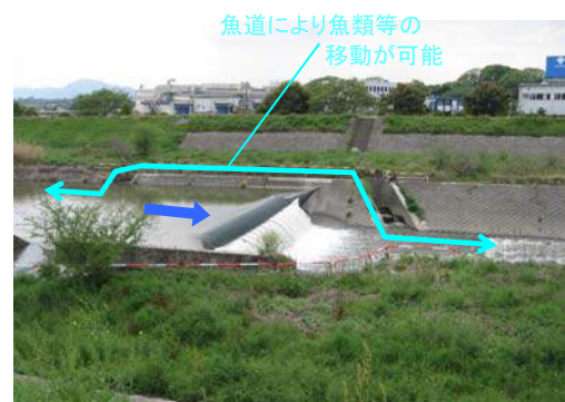
写真4.3 曾我川取水堰の魚道
