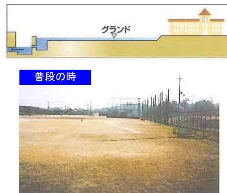
写真 1.22 雨水貯留浸透施設(まみがおか 広陵町立真美ヶ丘中学校)
