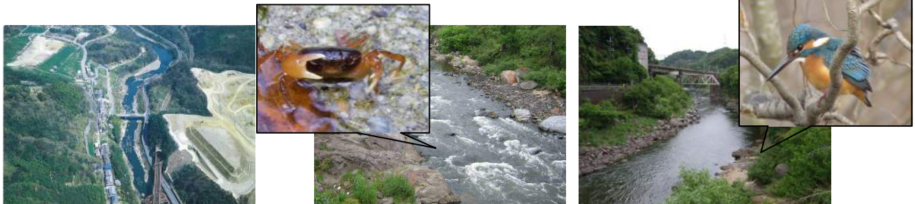
写真 1.28 亀の瀬の状況
