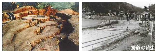
写真 1.24 昭和 42 年の地すべりによる被害
