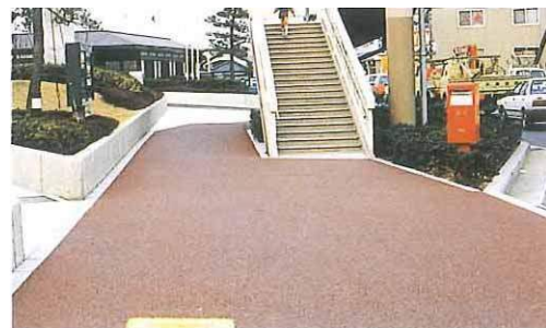
写真 1.21 透水性舗装(斑鳩町役場前)
