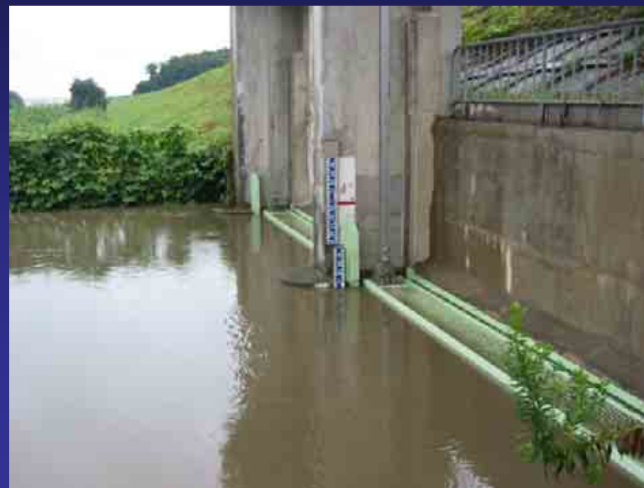
樋門は閉じた状態です。
