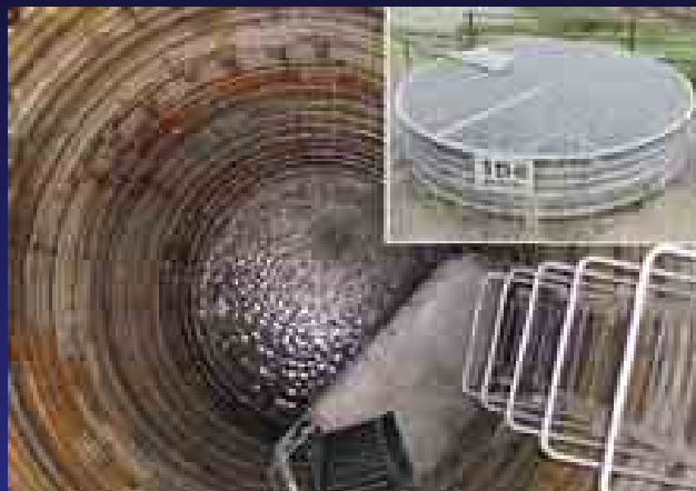
集水井工の内部 (右上は地上部の様子)
