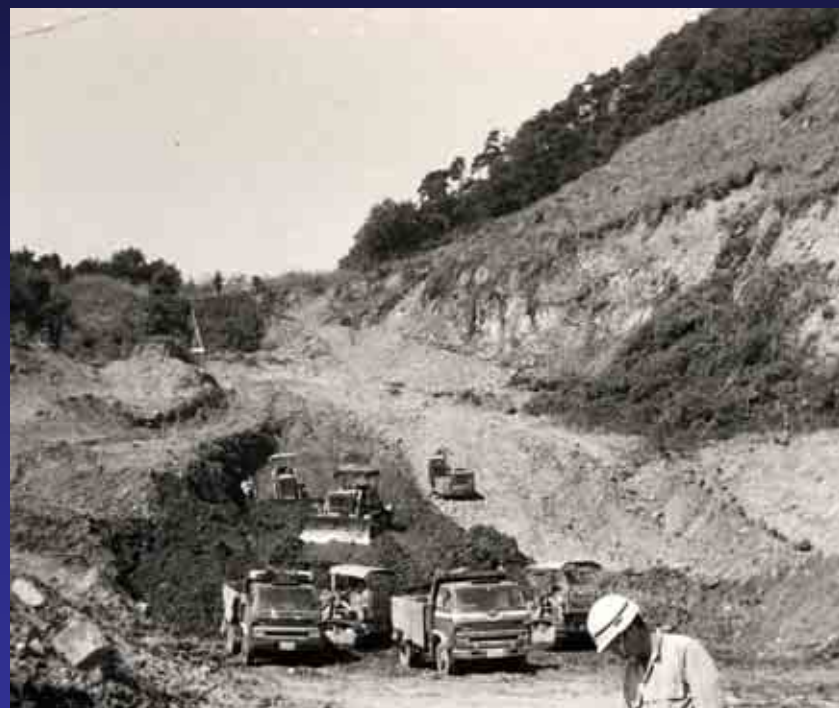
清水谷上部の排土状況
