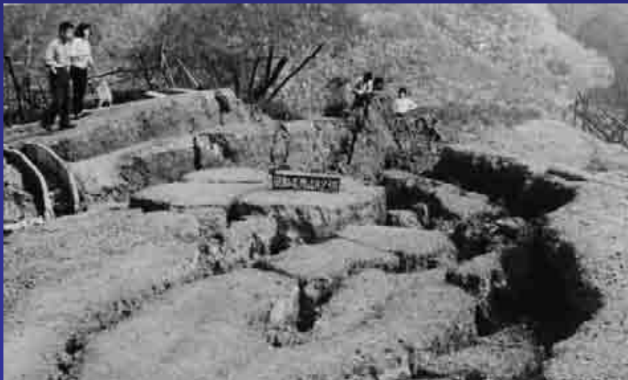
昭和42年 畑地の亀裂・陥没
