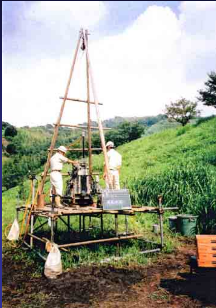
● 地質ボーリング調査状況
