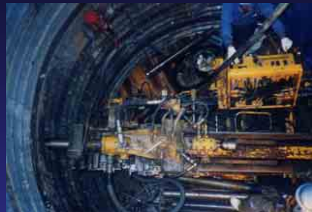
集水井内における集水ボーリング 施工状況
