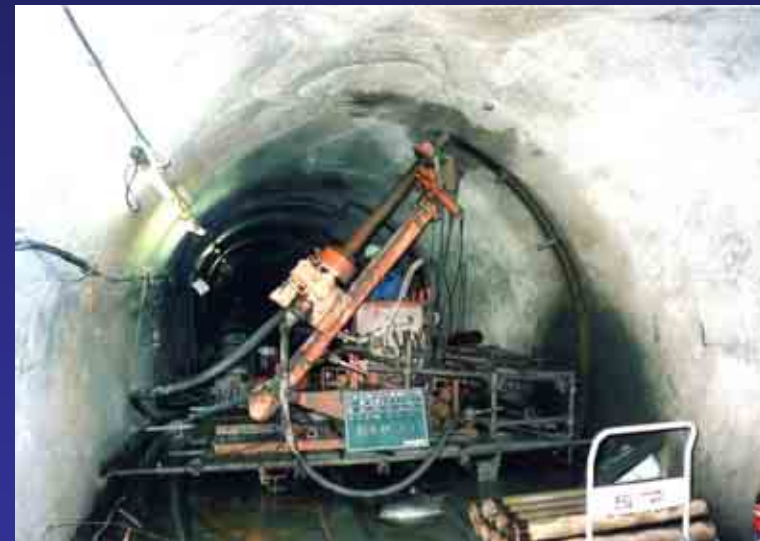
集水ボーリング施工状況
