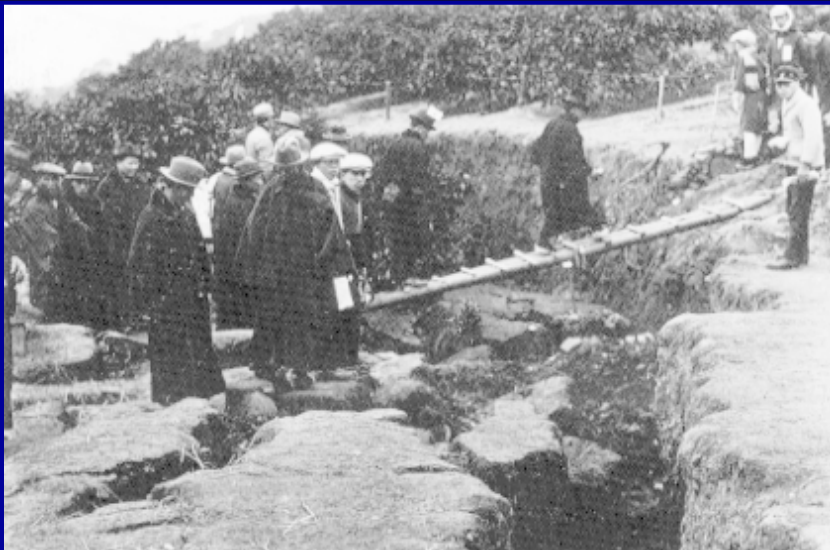
昭和6年 亀の瀬峠地区で起こった地すべりによる亀裂
