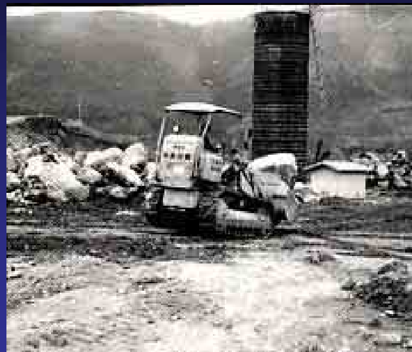
清水谷下部の排土状況
