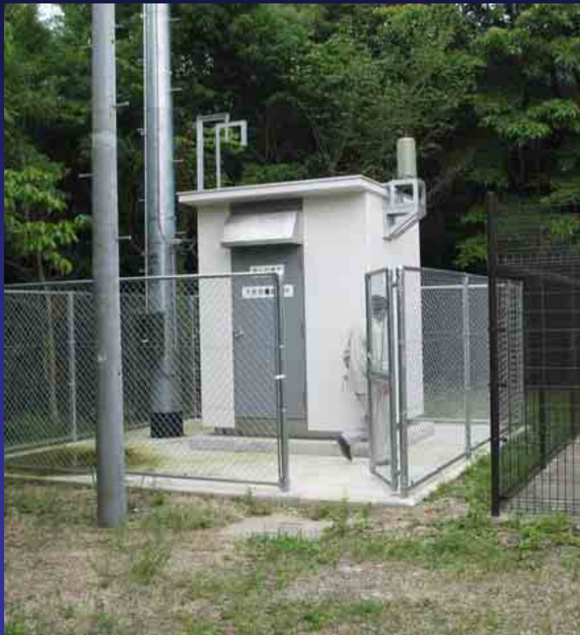
天見雨量観測所(大阪府河内長野市)
