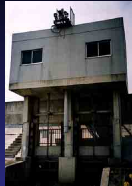
排水施設(樋門)
