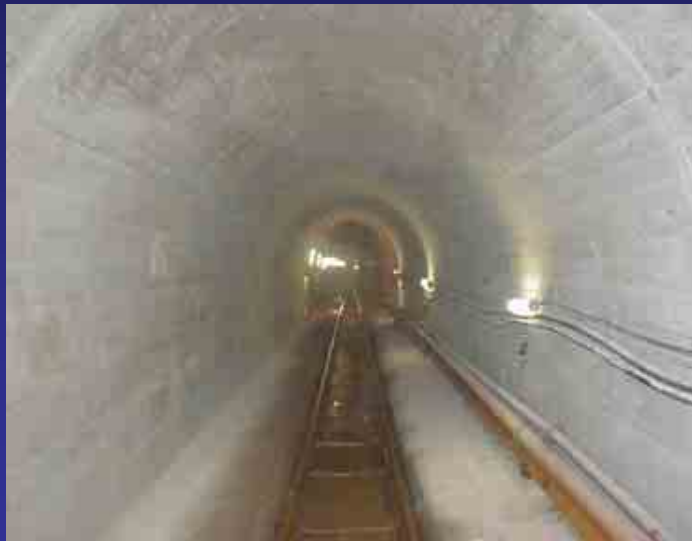
覆工後の内部(5号排水トンネル)
