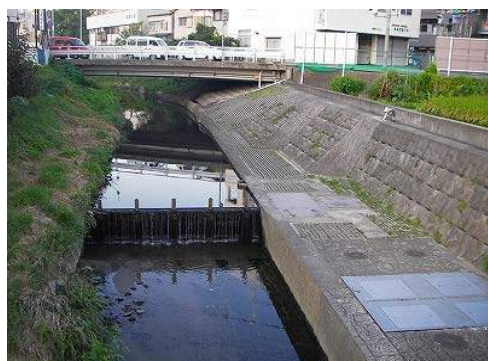
東生駒川総合浄化施設
