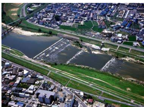
柏原地区 瀬と淵浄化施設
