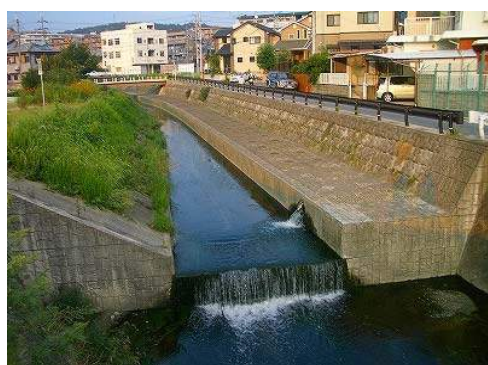
東生駒川総合浄化施設
