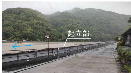
現地状況 (起立部)
