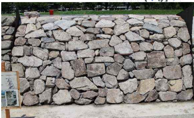
①京都近隣で左岸溢水対策区間の施工量を確保可能な「生野丹波石（兵庫県）」
