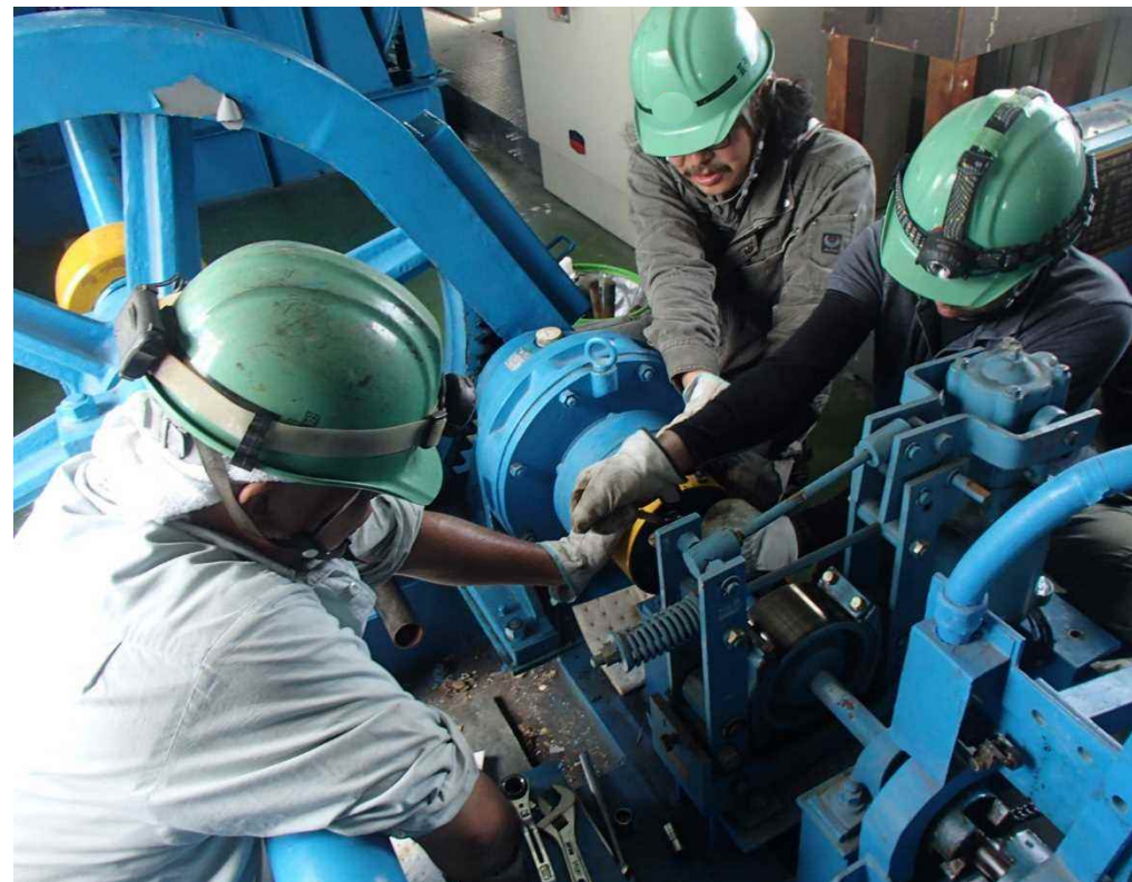
専門業者による詳細な点検 (水門の事例)
