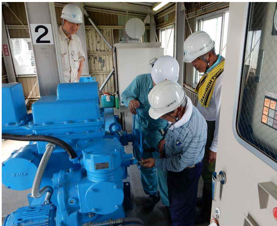
操作員(地元)による日常の動作確認 (樋門の事例)
