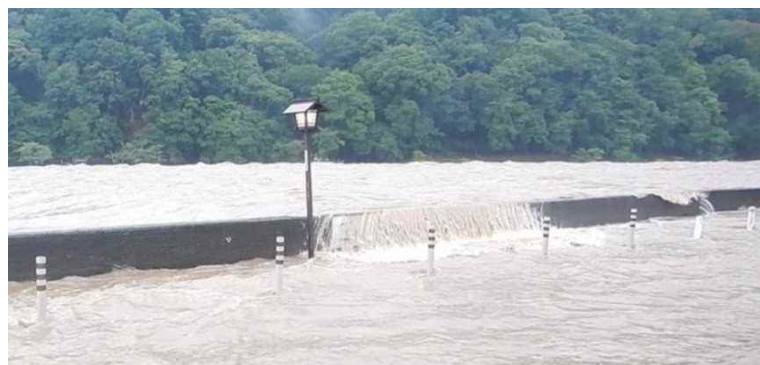
出水時のパラペット越流状況 (H30.7月豪雨)
