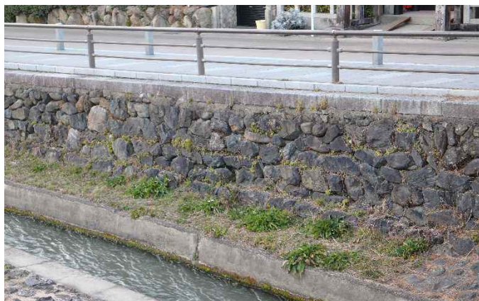
現在の石積み(渡月橋左岸上流)
