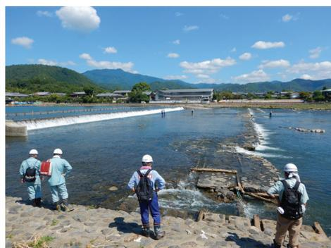
一の井堰護床工の被災状況確認
