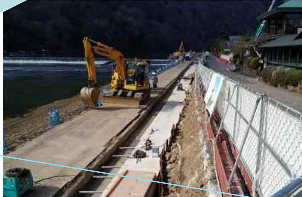
・ 3月第一週現在は、護岸コンクリートの打設及び仮護岸のための鋼製ユニットの設置を中心に実施。
