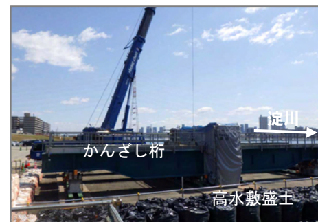
⑥既設橋梁補強桁搬入
