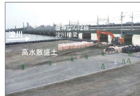
③高水敷盛土
