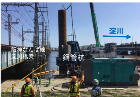
⑤鋼管杭打設
