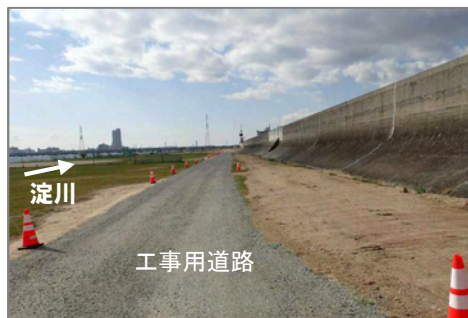
①工事用道路
