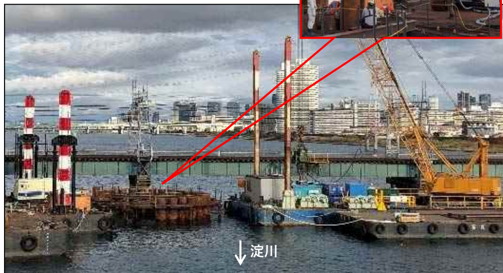
③鋼管矢板井筒基礎工
