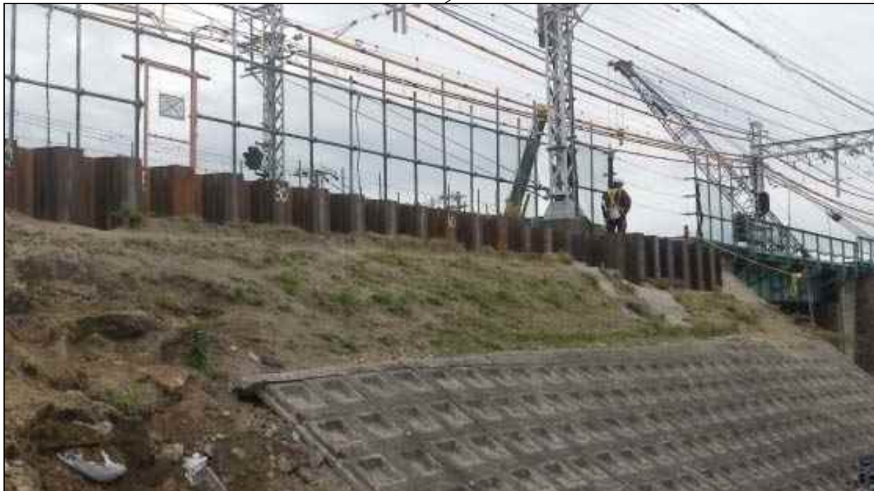
鋼矢板打設工
