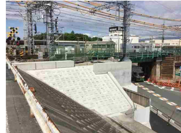
④仮橋台工
