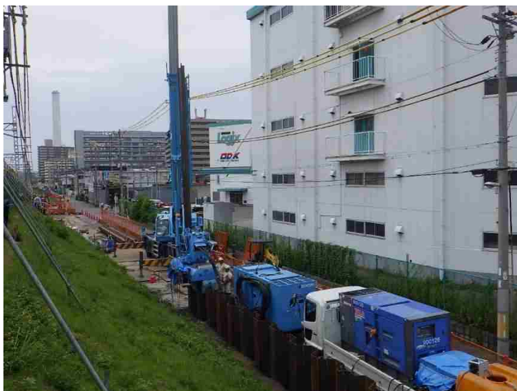
③仮線構築工（鋼矢板圧入工）
