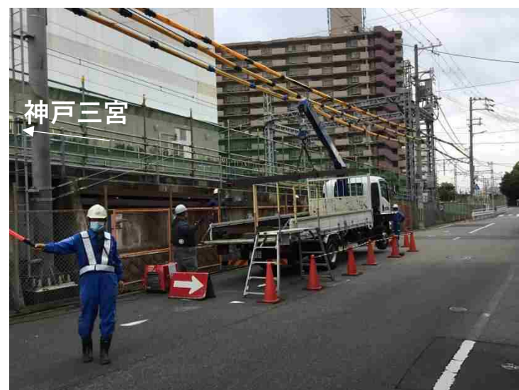
④仮線構築工（腹起し設置）
