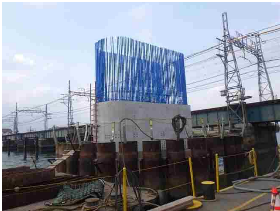
②橋脚構築工
