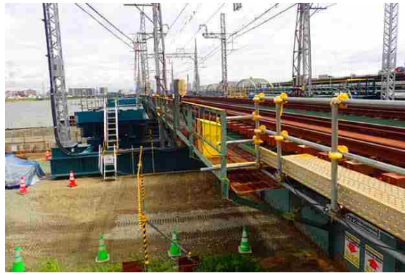
①仮線橋梁工
