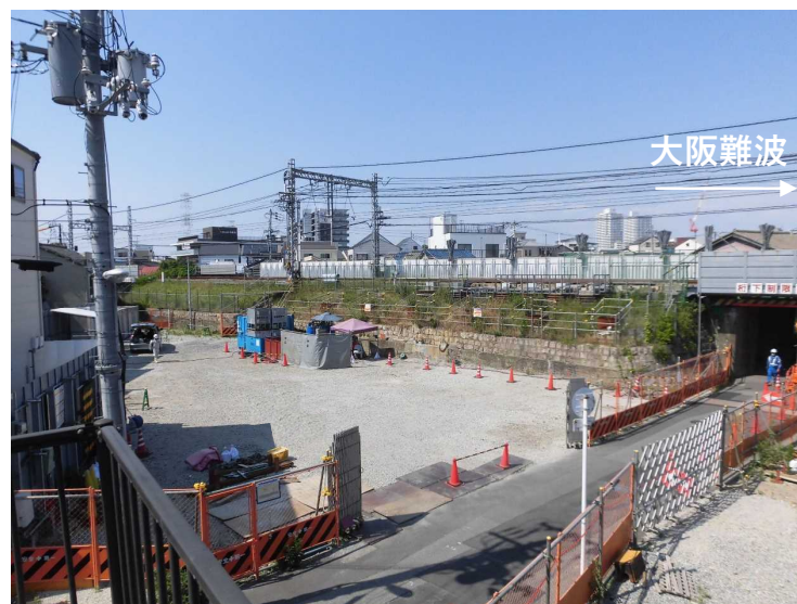
③工事桁工（進入路整備工）
