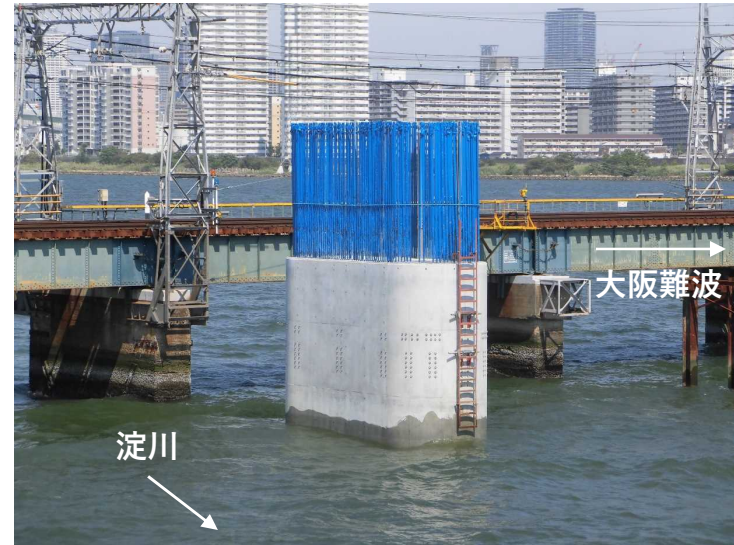
②橋脚構築工
