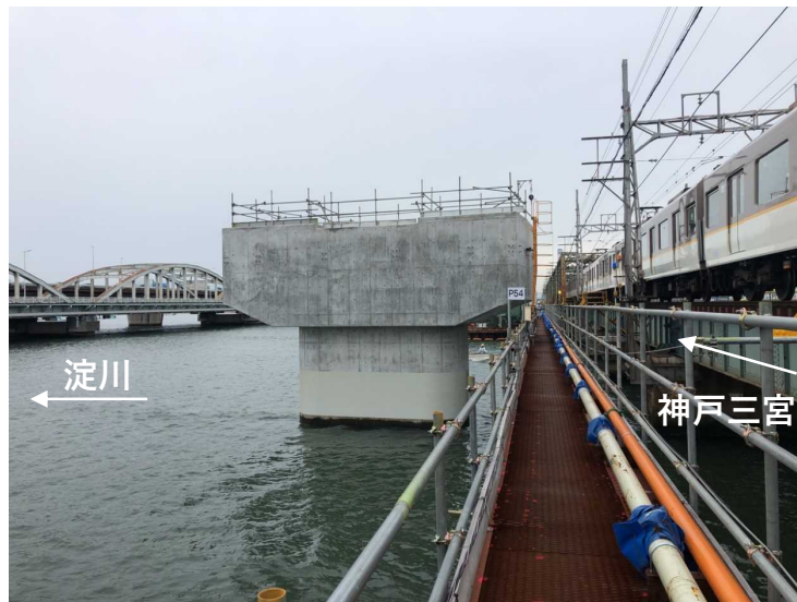
③梁構築工
