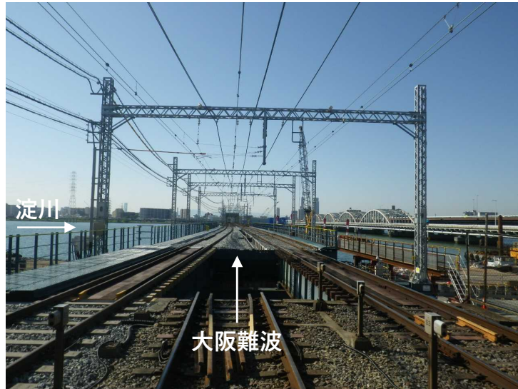
①仮線橋梁工
