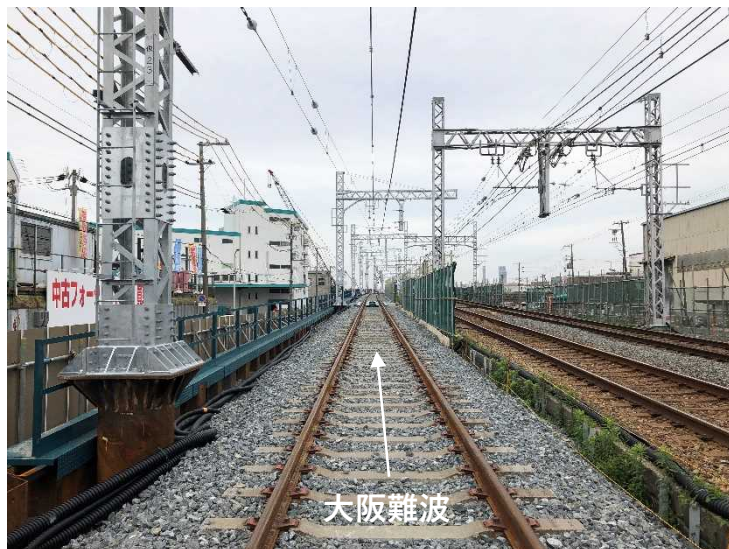
①仮線構築工
