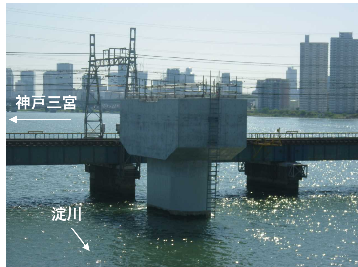
③梁構築工
