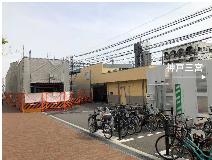
③仮駅舎工
