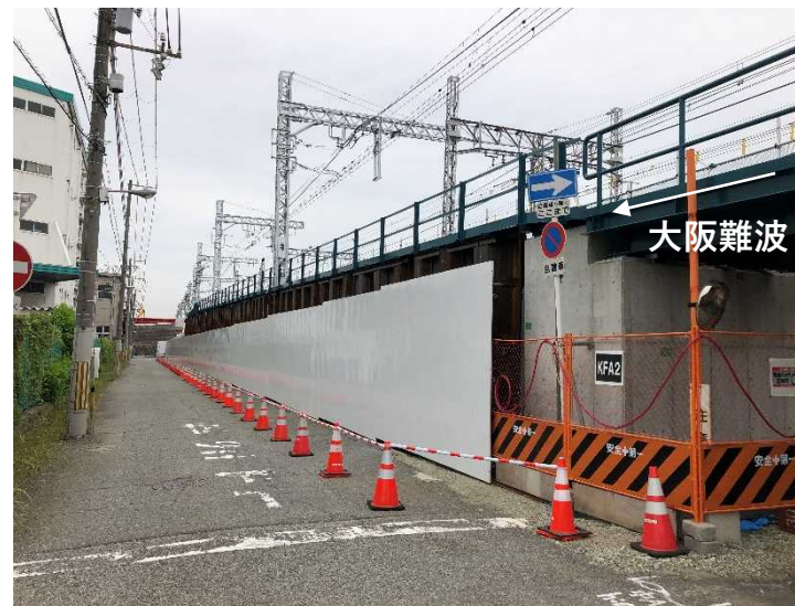
②万能板設置工
