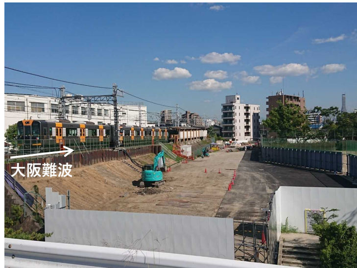
①伝法駅部仮土留工
