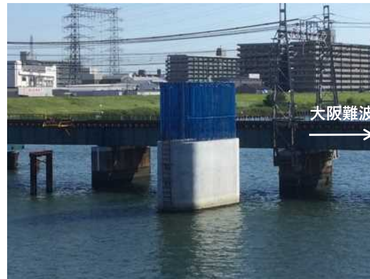
②橋脚構築工
