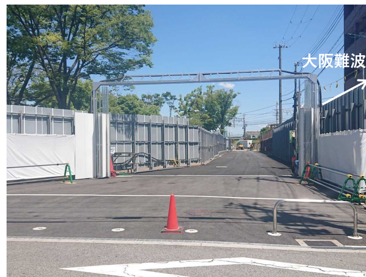
②工事ヤード整備工（進入路整備工）
