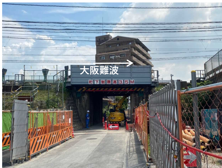
③工事桁支持杭打設工
