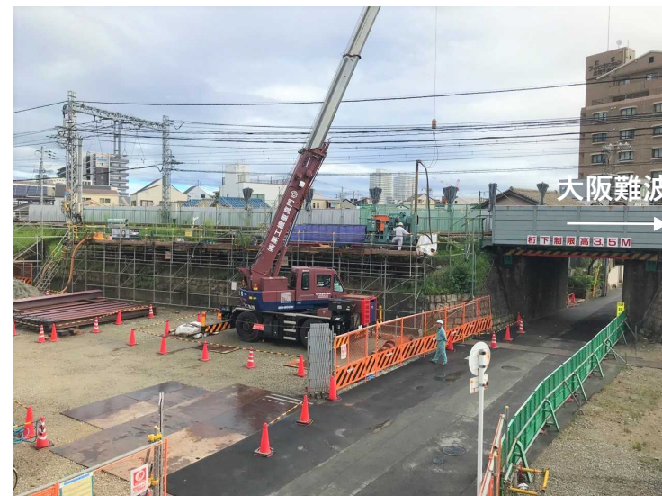
②仮設構台設置工（H鋼杭打設）
