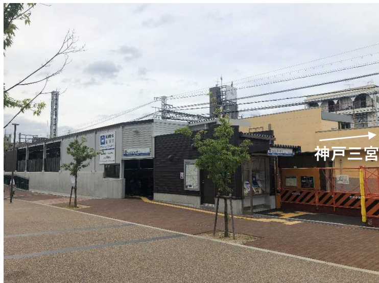
①仮駅舎構築工
