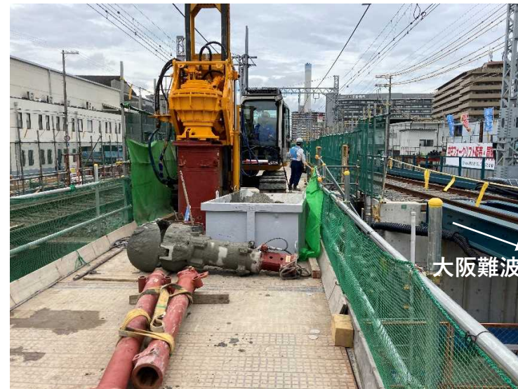
②障害物撤去工
