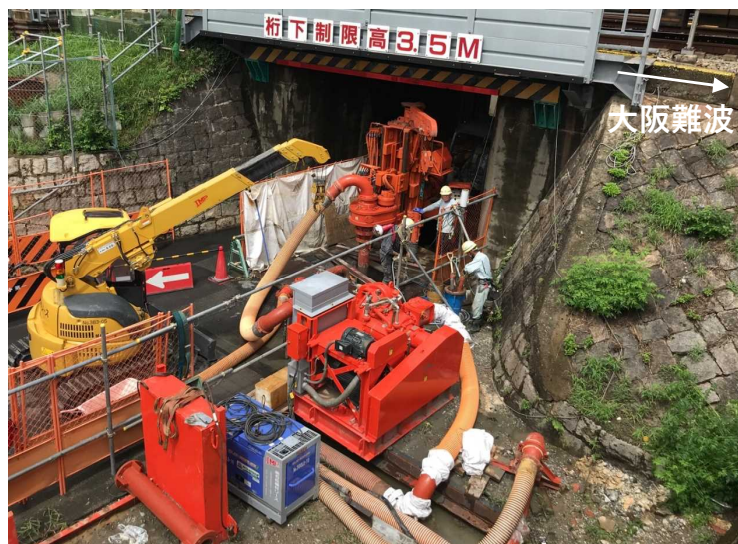
③工事桁支持杭打設工
