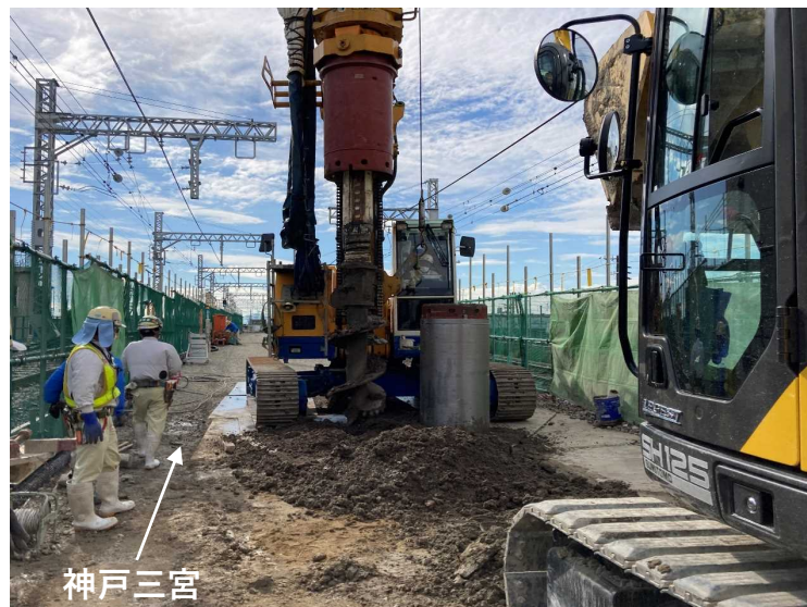
③障害物撤去工
