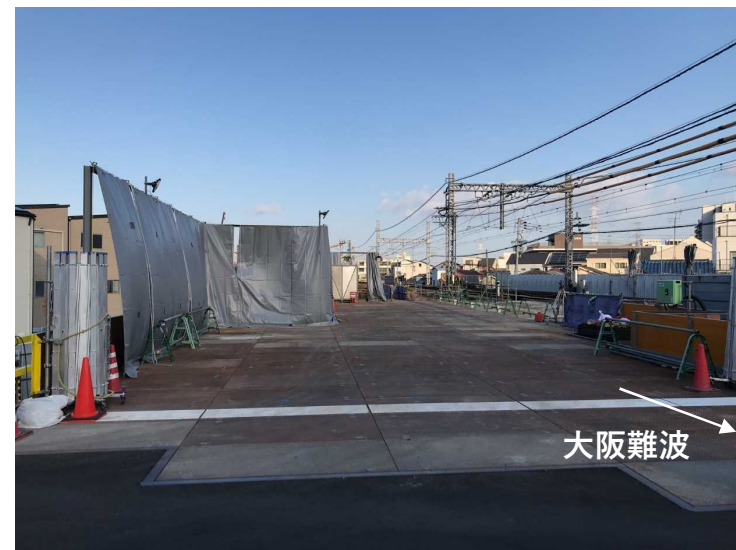
②仮設構台設置工
