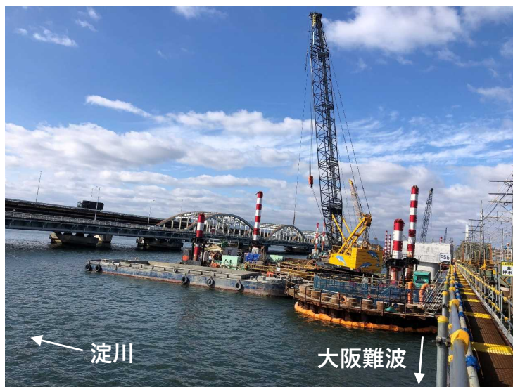
③鋼管矢板井筒基礎工（井筒内掘削）
