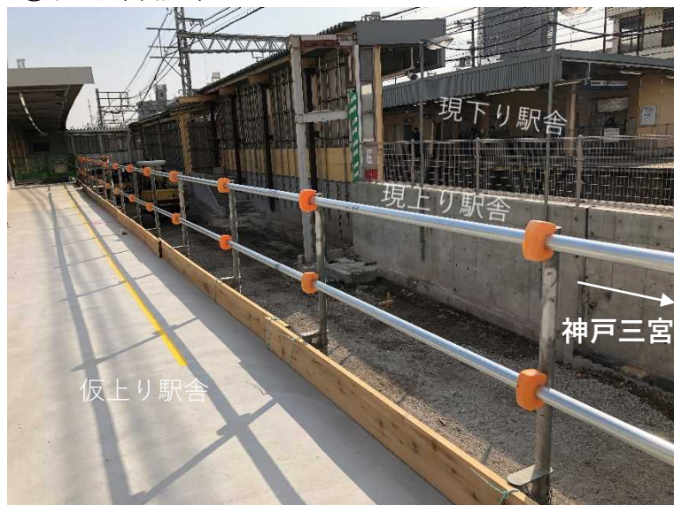
①仮駅舎構築工
