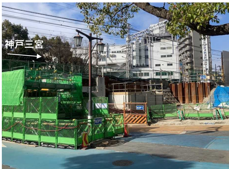
③仮線構築工（橋脚構築工）
