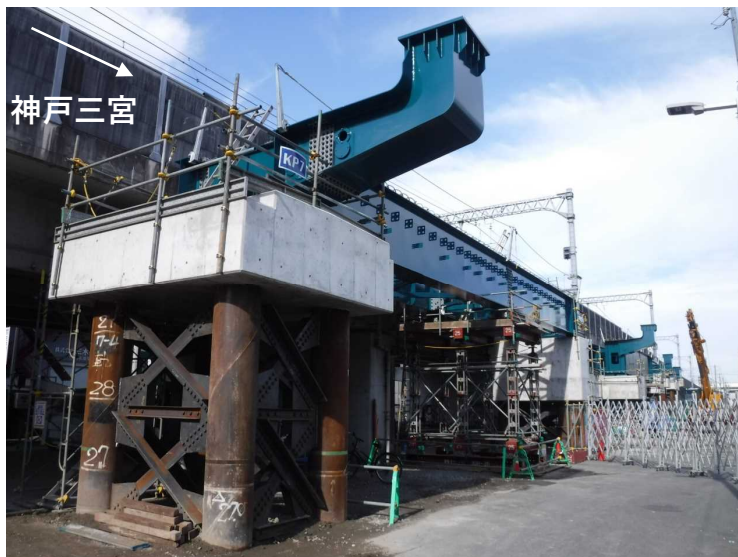
①仮線桁架設工
