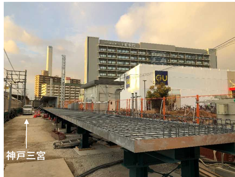
②仮駅舎構築工
