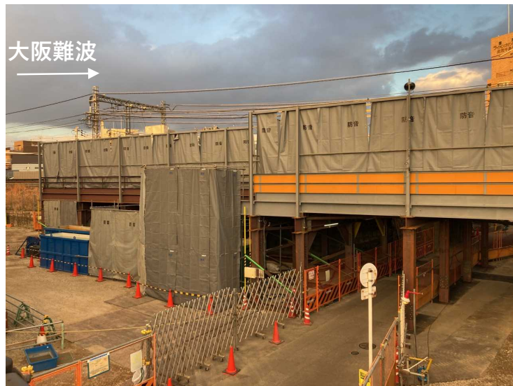
①仮設構台設置工
