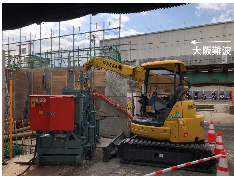
③仮線構築工（基礎杭工）
