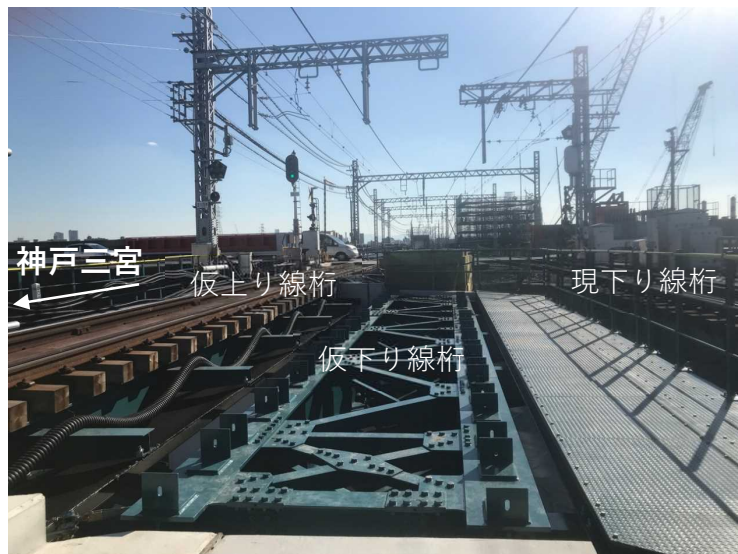
③仮線桁架設工
