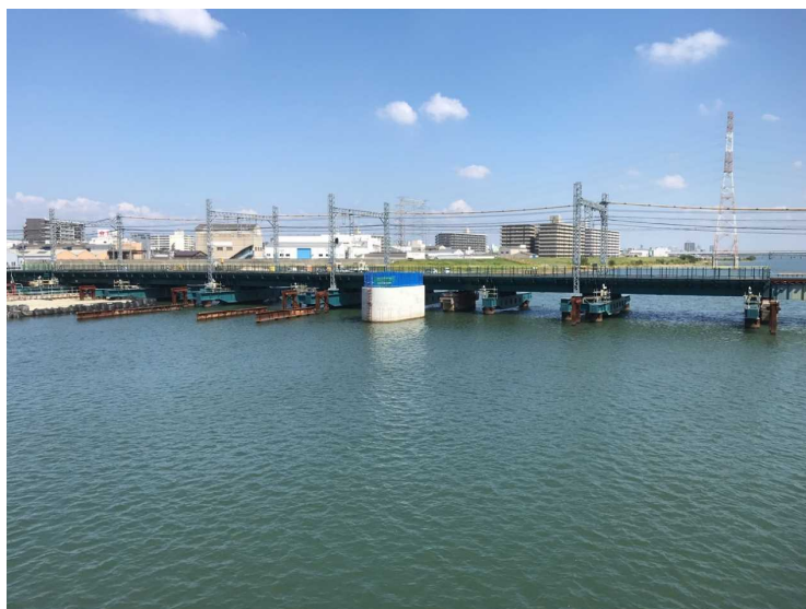
②P47ニューマチックケーソン基礎工（柱構築）
