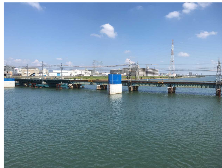
③P48鋼管矢板井筒基礎工（柱構築）
