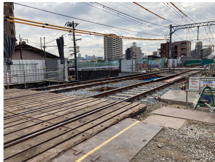
②かんざし桁P1土留め設置工
