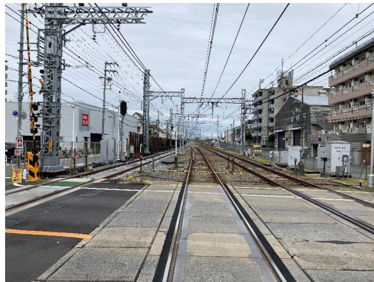
②仮線構築工（仮上り線切替）
