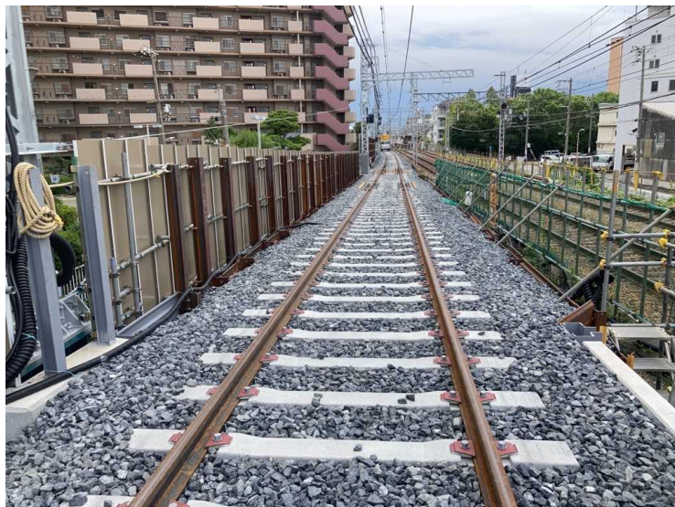
③仮線構築工（仮上り線切替）
