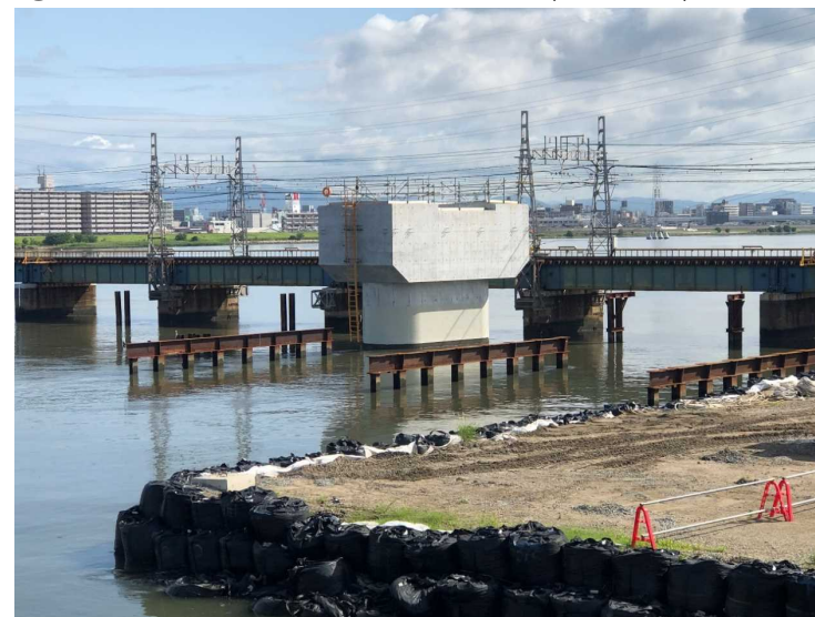
②オープンケーソン基礎工（梁構築）
