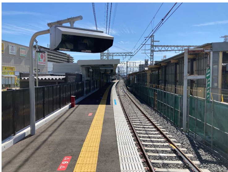
③仮駅舎構築工（仮福駅上りホーム供用開始）
