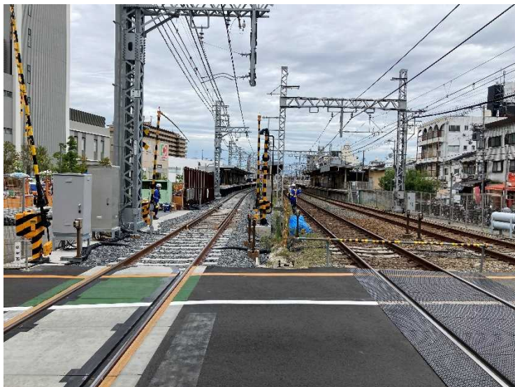
①仮線構築工（仮上り線切替）
