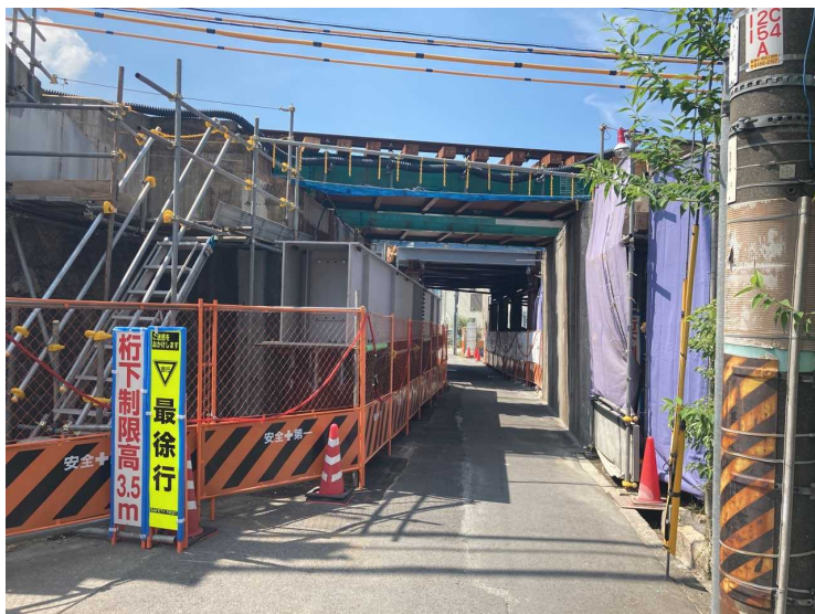
①かんざし桁P2架設工
