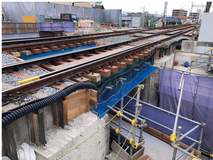
③既設橋台撤去工
