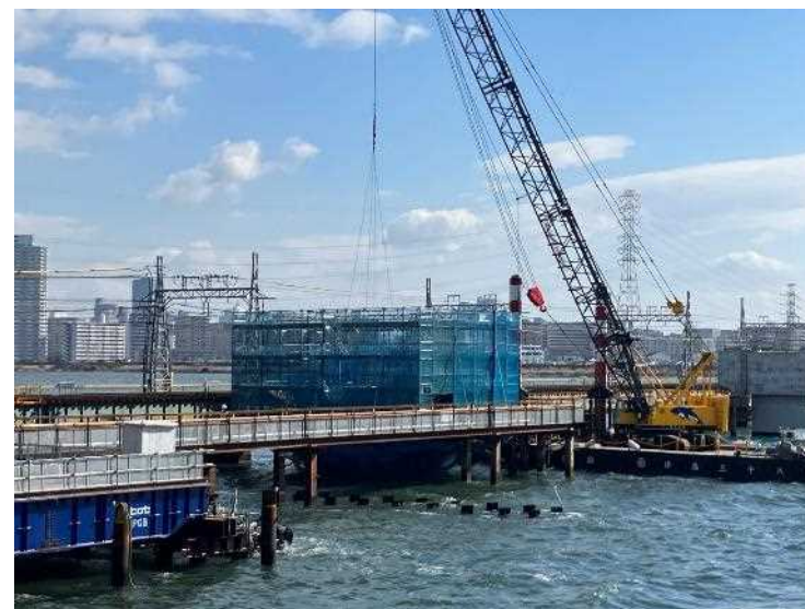
② P48鋼管矢板井筒基礎工（梁鉄筋組立）
