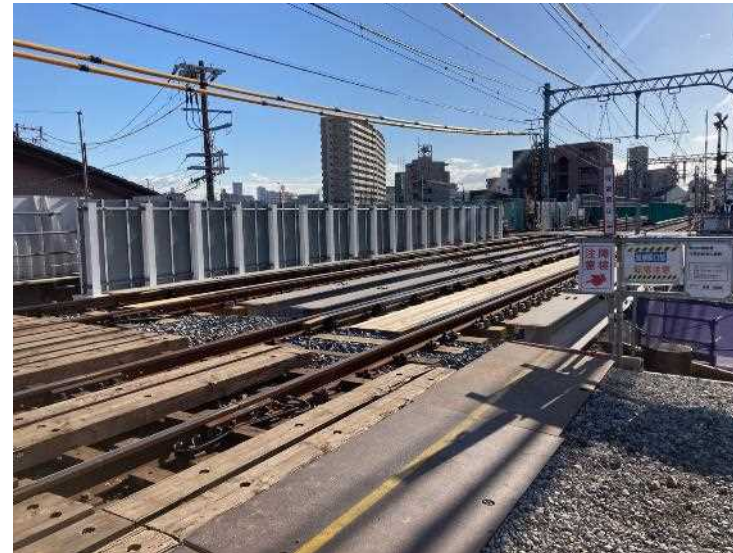
②工事桁工
