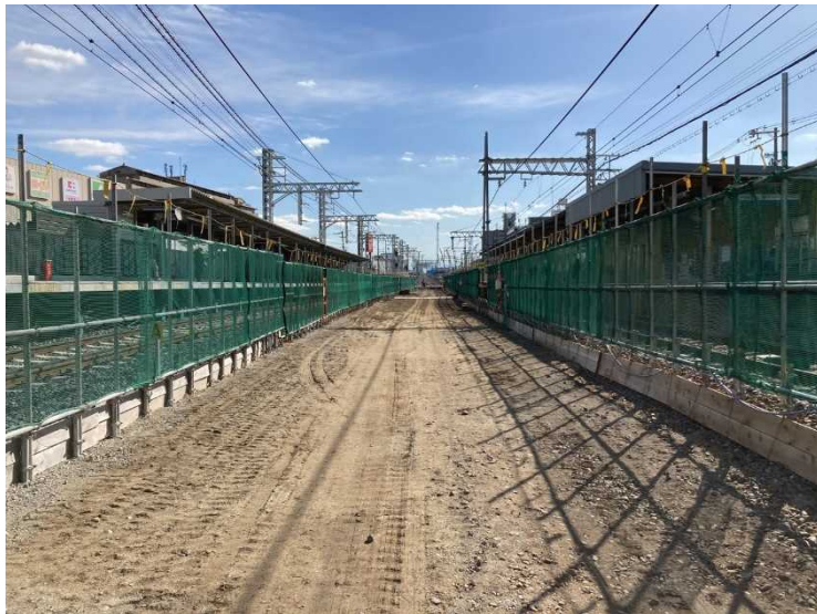
①現在施設撤去工（旧上りホーム撤去）
