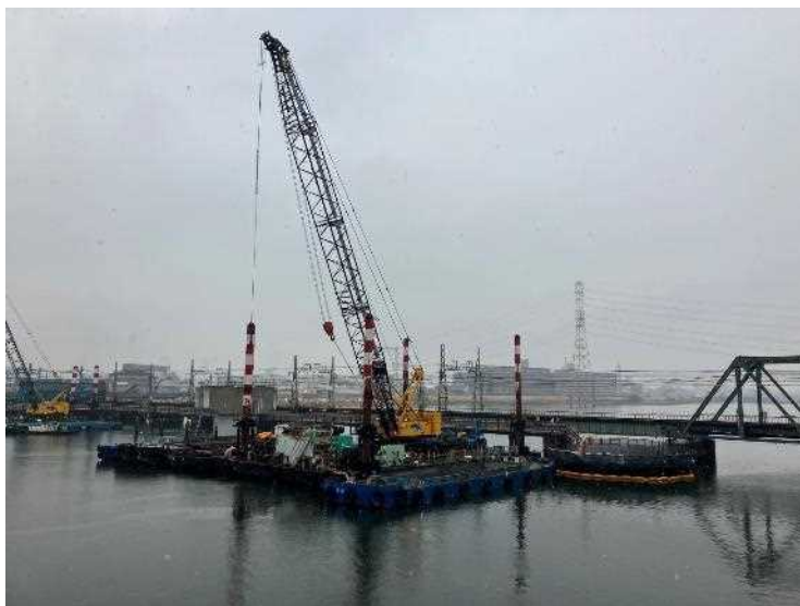
③P50鋼管矢板井筒基礎工（井筒内支保工設置）
