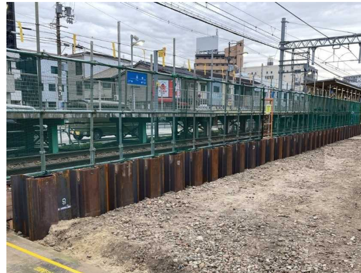
②鋼矢板打設工
