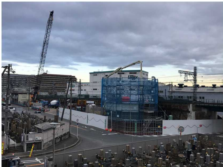
③P50鋼管矢板井筒基礎工（井筒内支保工設置）
