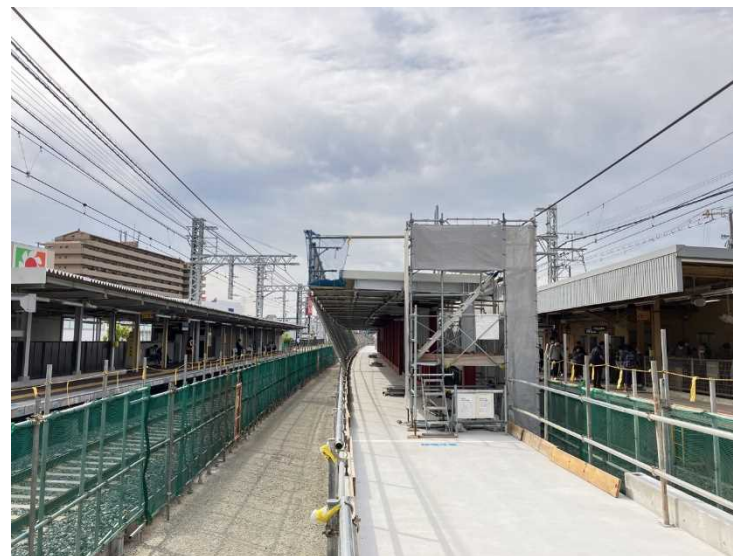
②仮駅舎構築工（屋根、外壁設置）
