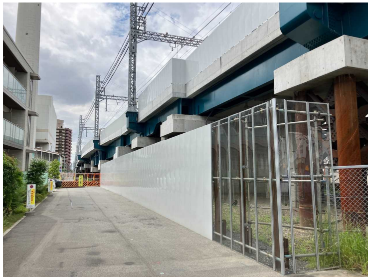
①側道復旧工（淀川通り側）
