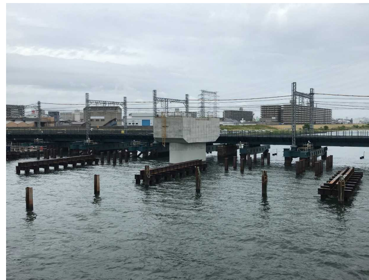
④P50鋼管矢板井筒基礎工（躯体構築完了）
