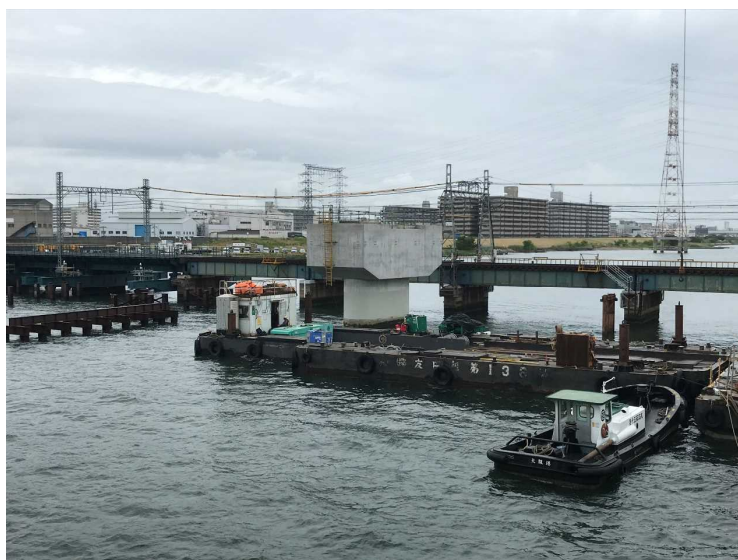
③P48鋼管矢板井筒基礎工（梁構築完了）
