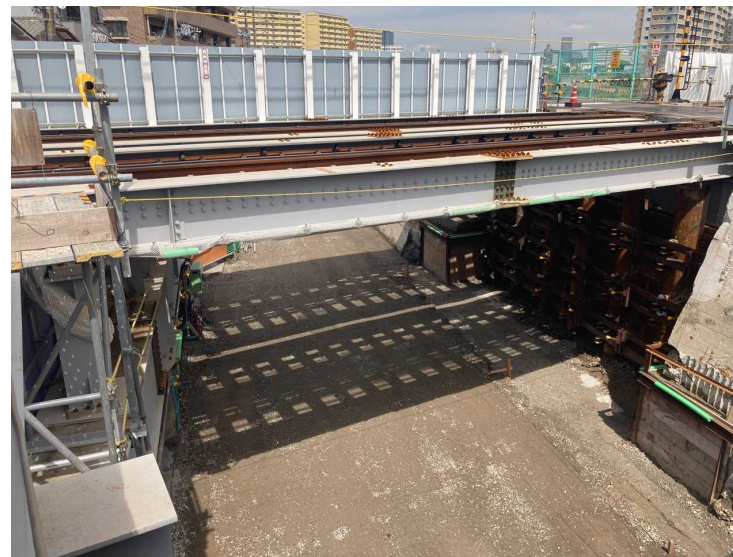
②既設橋台撤去工
