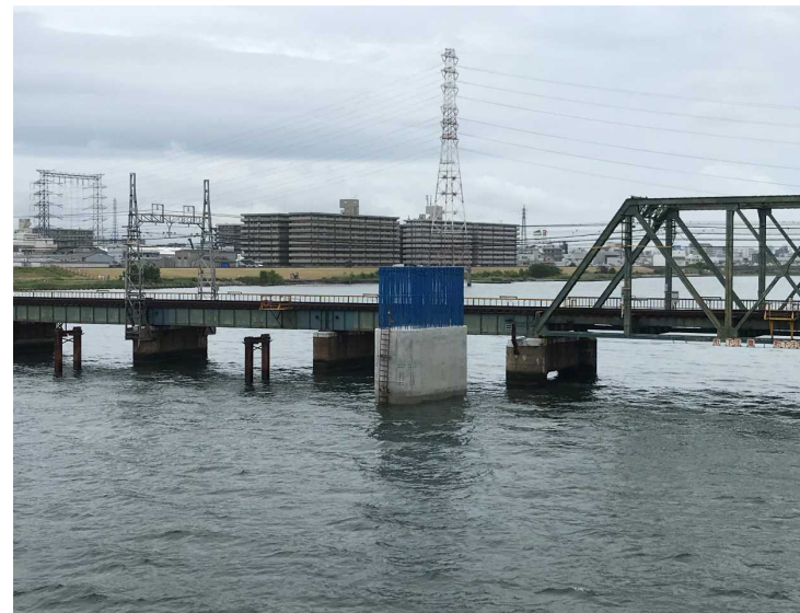
④P50鋼管矢板井筒基礎工（躯体構築完了）
