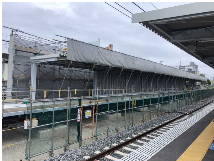
③仮駅舎構築工（屋根、外壁設置）
