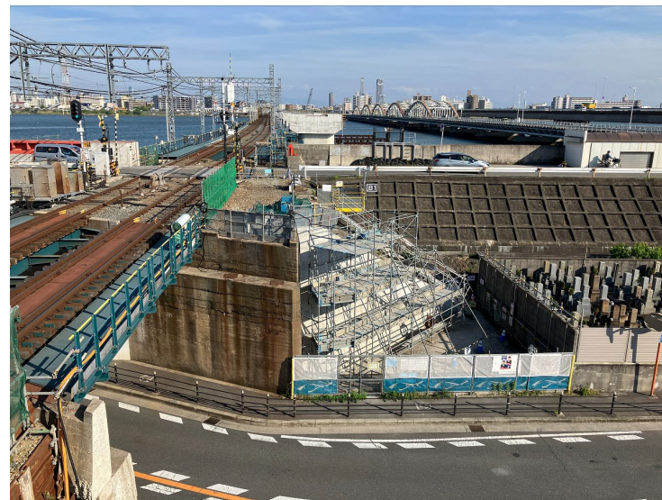
② B1ベント基礎工（既設石積擁壁補強状況）
