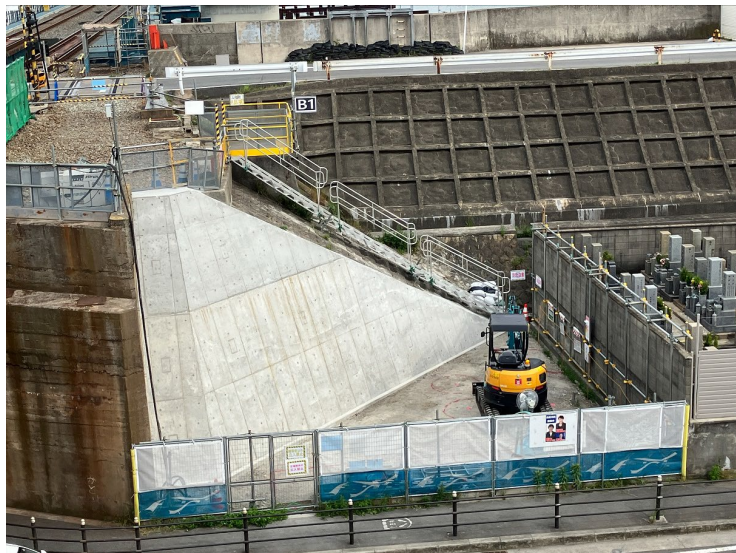
③ B1ベント基礎工（既設石積擁壁補強完了）
