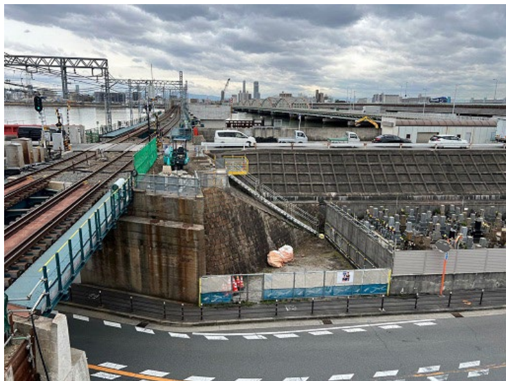
③ B1ベント基礎工（既設石積擁壁補強完了）
