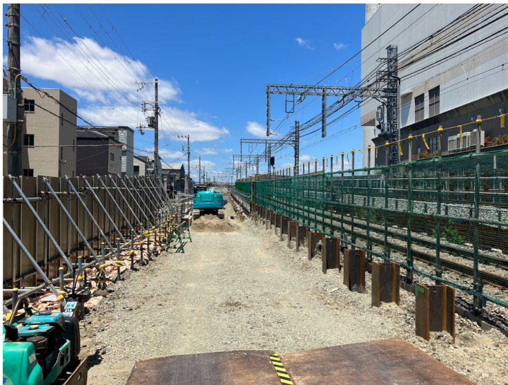
①仮土留設置工
