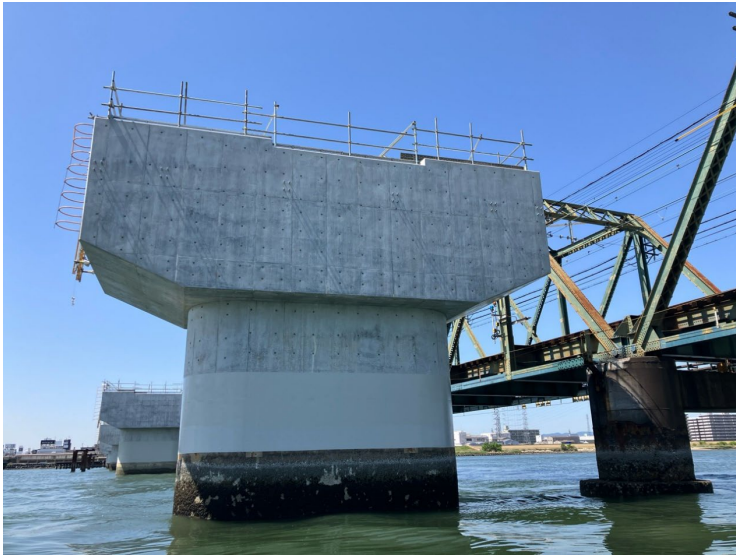
① P52鋼管矢板井筒基礎工（梁構築完了）
