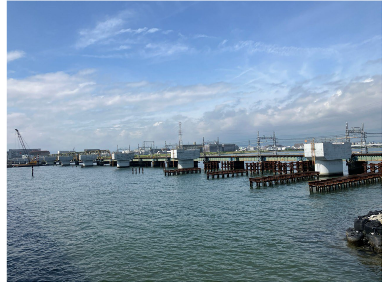
②P52鋼管矢板井筒基礎工（仮設備解体状況）
