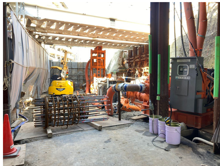
②場所打ち杭工
