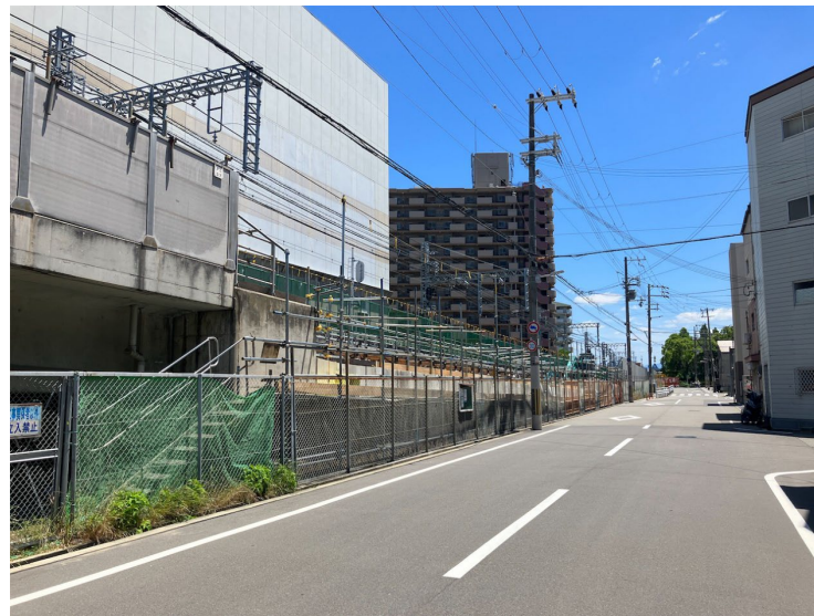
②擁壁撤去工
