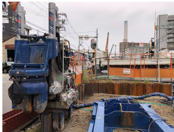
②鋼矢板打設工
