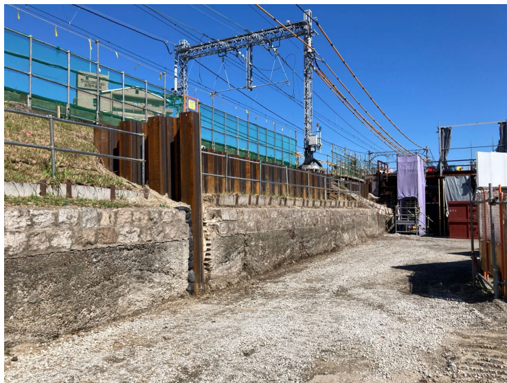
①鋼矢板圧入工
