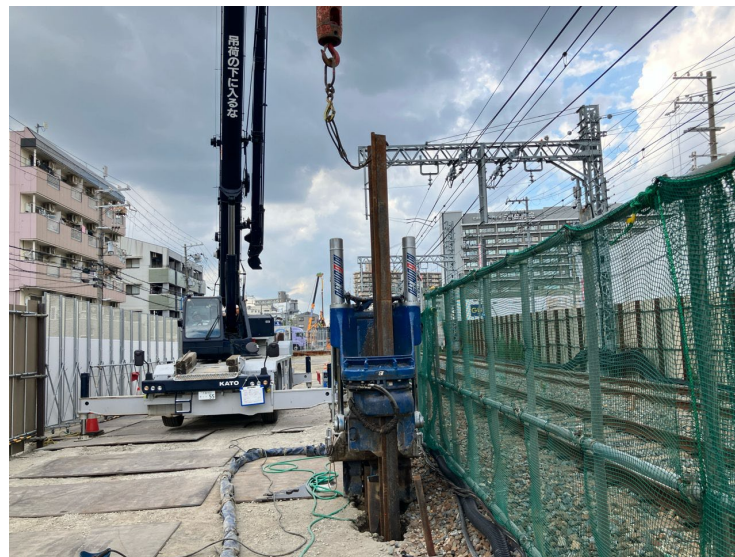
②鋼矢板打設工
