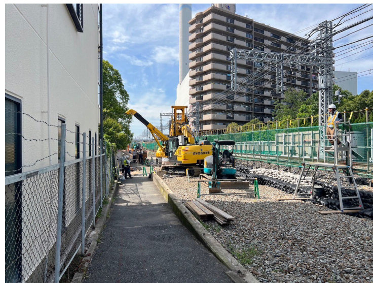
②支障物撤去工
