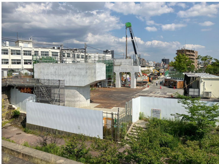
③上部工架設準備工
