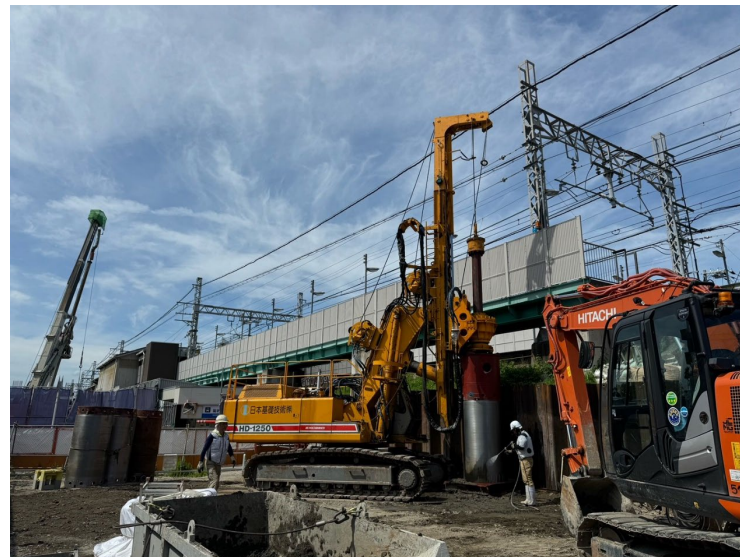
②障害物撤去工
