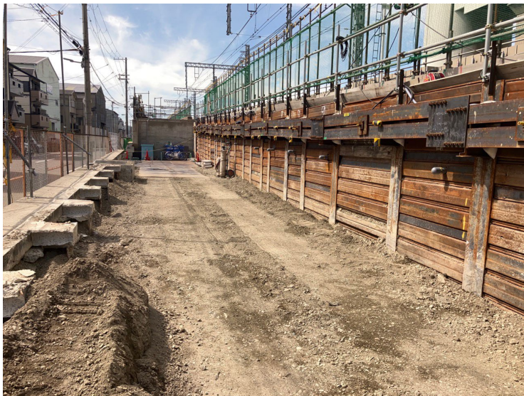
①擁壁撤去工
