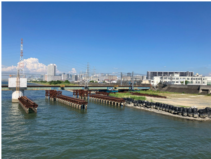
① 河川内状況
