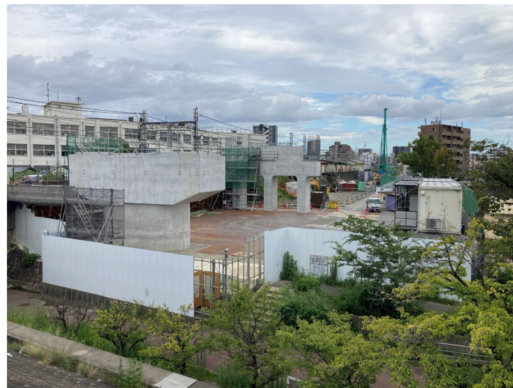
② 上部工架設準備工
