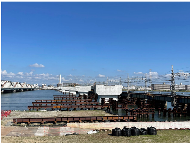
① 河川内状況
