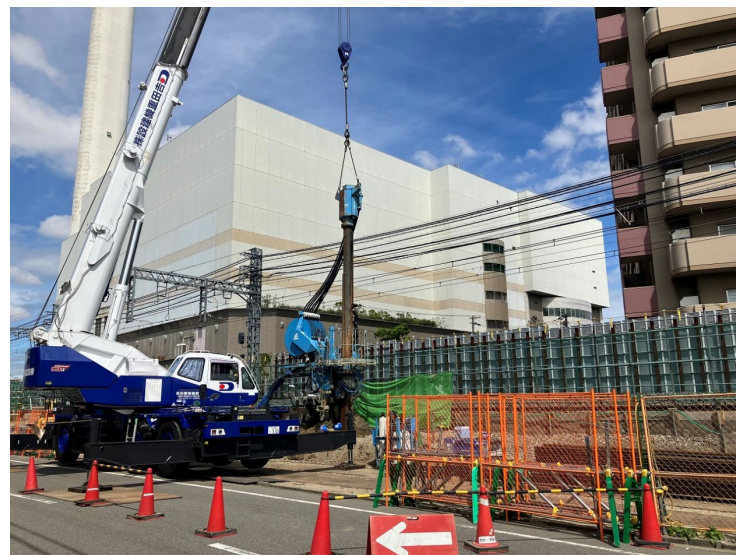
②鋼矢板圧入工
