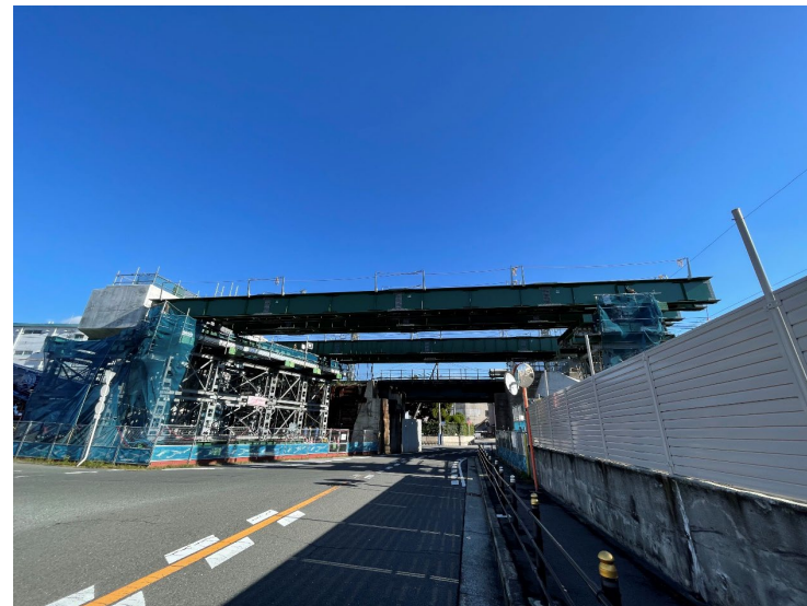
④ 上部工架設準備工（工事桁架設）
