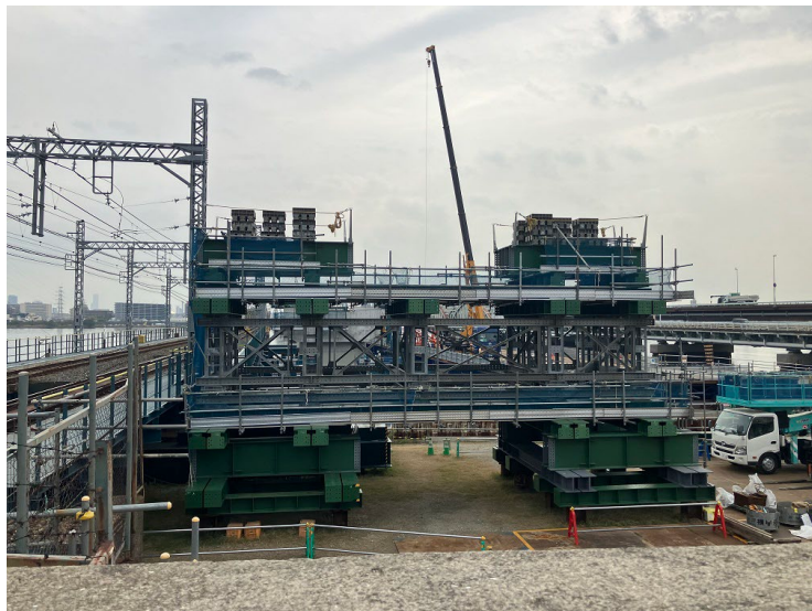
③ 上部工架設準備工（ベント設備組立）
