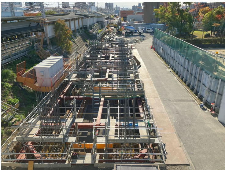
③ボックスカルバート据付完了（車道側）
