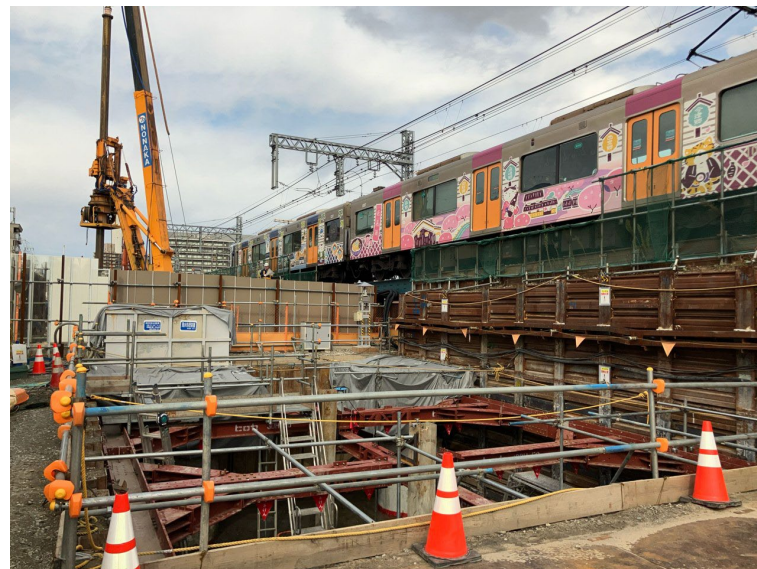
④躯体構築工（掘削、床付け）
