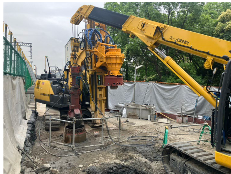
②障害物撤去工
