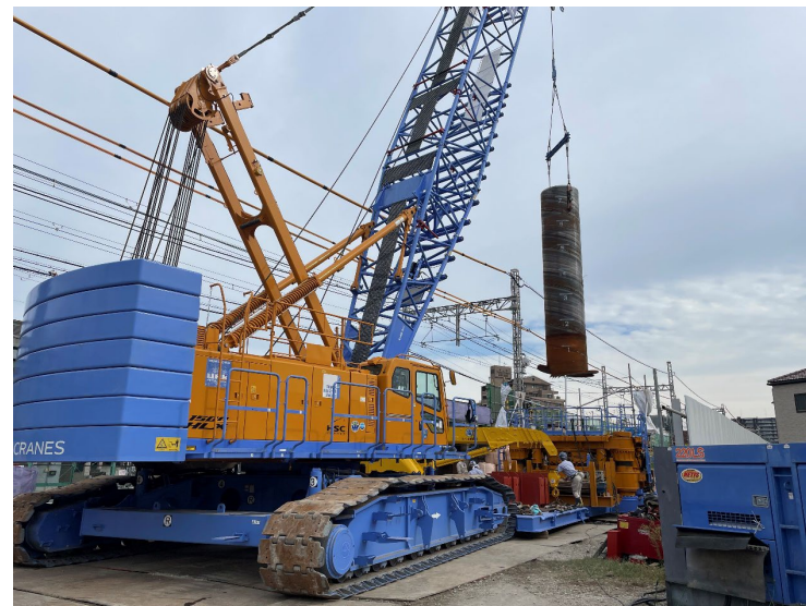
②鋼管杭打設工
