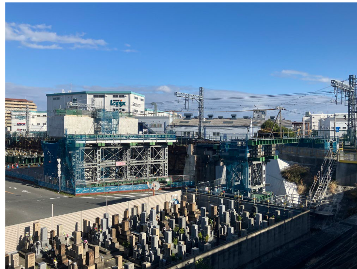
④ 上部工架設準備工（工事桁架設）
