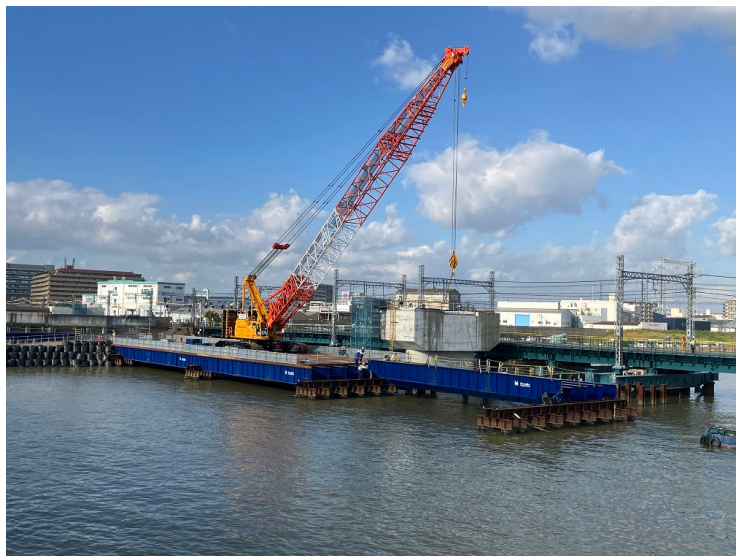
① 上部工架設準備工（栈橋構築）
