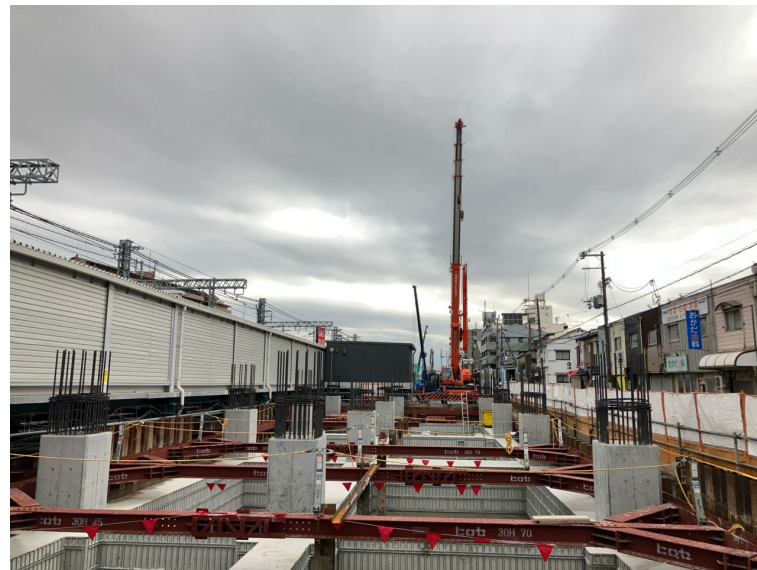
④躯体構築工（掘削、床付け）
