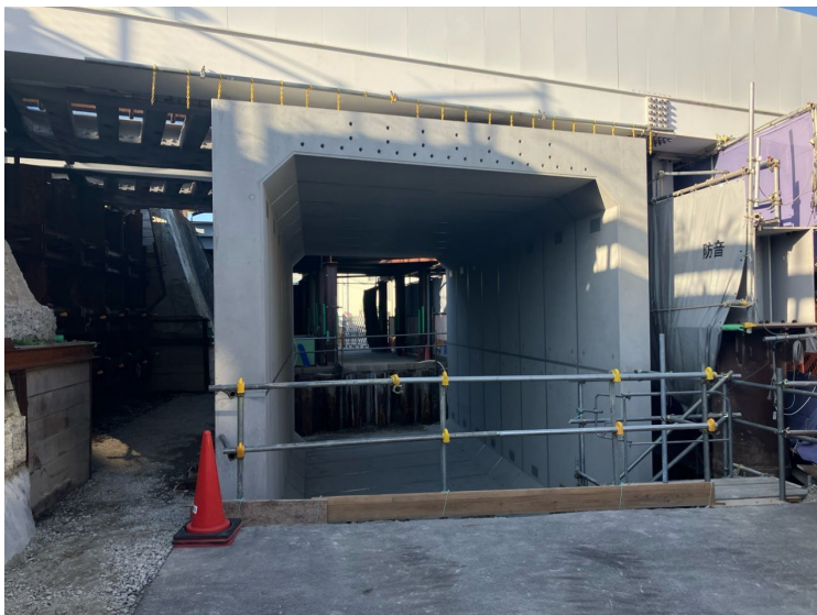
③ボックスカルバート据付完了（車道側）
