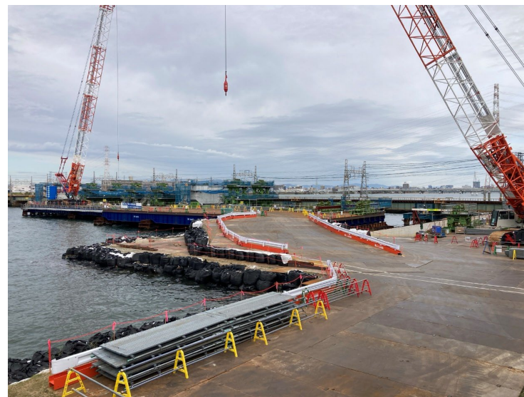
② 上部工架設準備工（斜路、栈橋構築）
